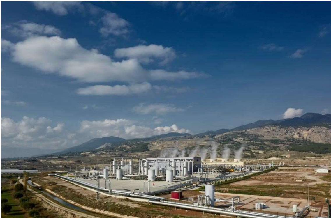
Abbildung 34: Geothermie Kraftwerk Kizildere III [45]
