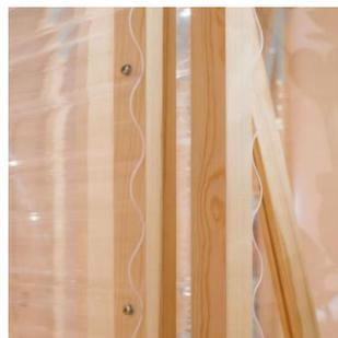
Befestigung Polycarbonat Wellplatten auf Holzständerkonstruktion
