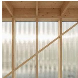
Die Raumboxen werden in Holzbauweise hergestellt. Transparente Flächenelemente, die keinen thermischen Anspruch erfüllen müssen, werden aus Polycarbonat Wellplatten hergestellt.
