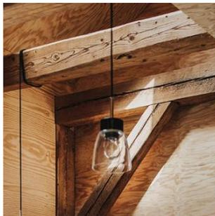
Die neu hinzugefügten Raumboxen und Wandverkleidungen werden mit Birkensperrholzplatten beplankt. Ein Großteil der bestehenden Dachstuhlkonstruktion bleibt sichtbar.
