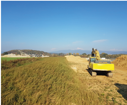
[Abb.52] Erweiterung des Baggersees Phase 1
