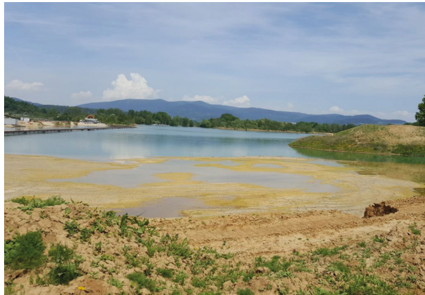
[Abb.53] Erweiterung des Baggersees Phase 2
