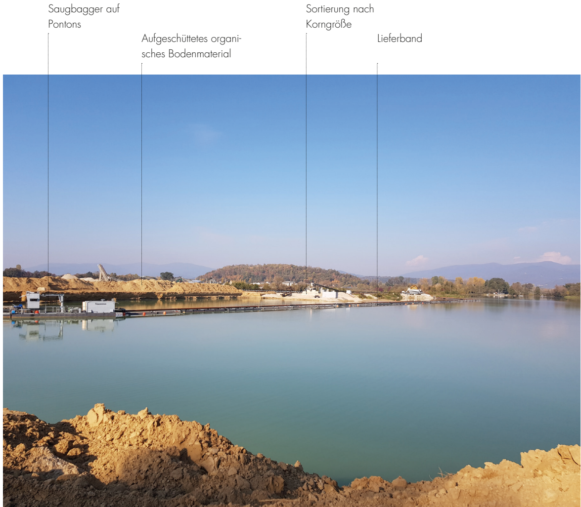
[Abb.50] Kieswerk am See
