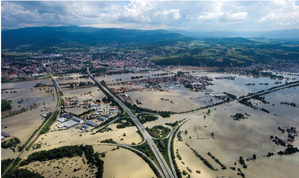
[Abb.16] Luftbild Autobahnkreuz; Hochwasser 2013
