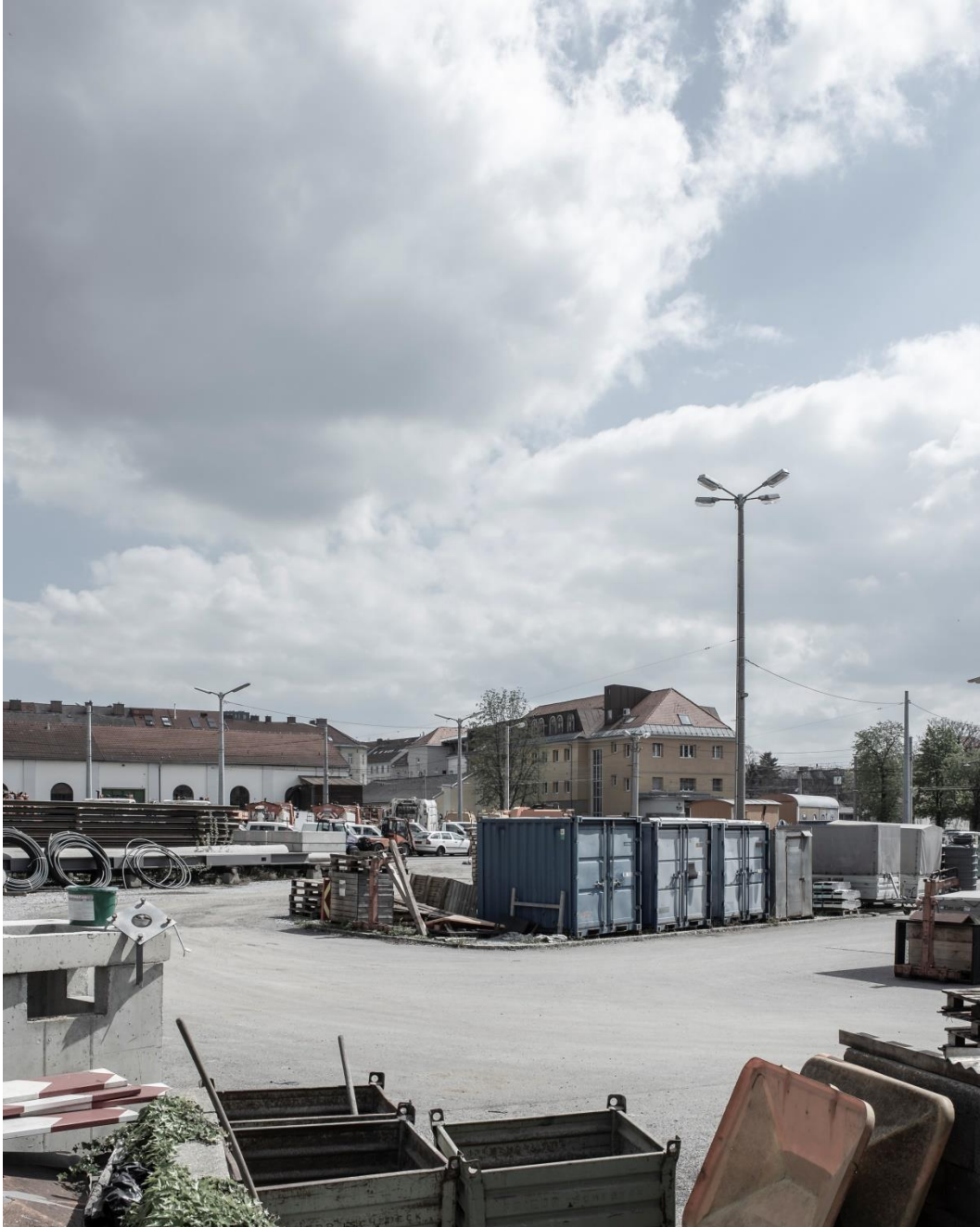
Abbildung 35: Ansicht ins Baugebiet Brockmannsgasse
