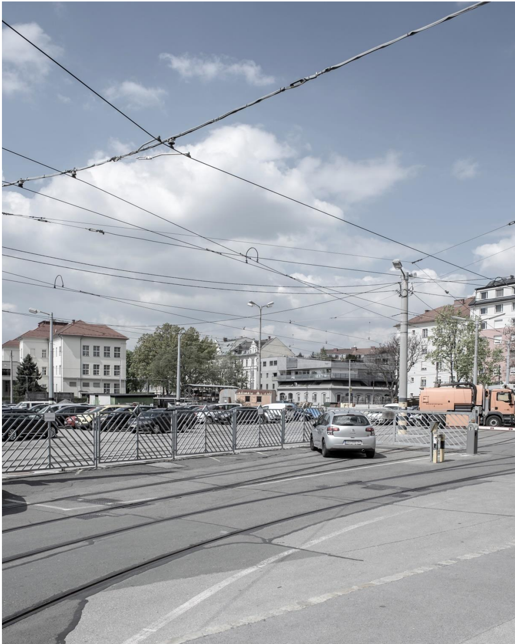
Abbildung 38: Gleisverlauf in den Abstellbereich im Freien
