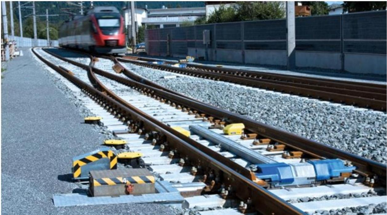
Abbildung 1: Eingebaute Weiche der voestalpine [1]
