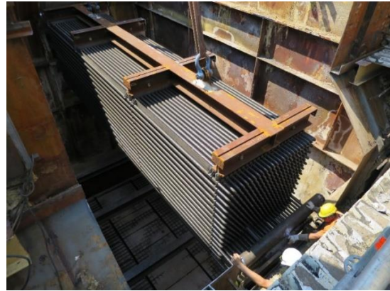
Abbildung 147 - Einheben eines neuen Heizflächenbündels
