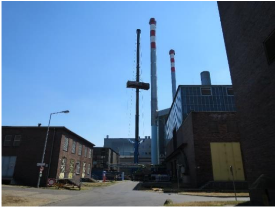
Abbildung 146 - Demontage eines alten Heizflächenbündels (Bild 2)
