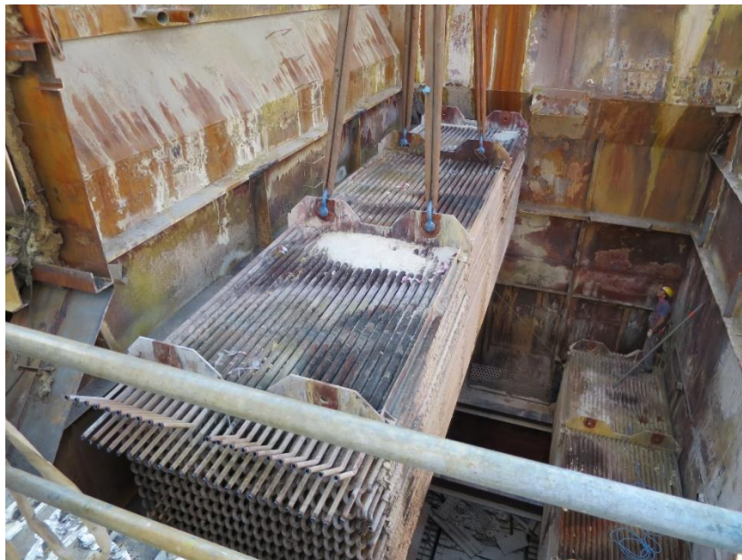
Abbildung 145 - Demontage eines alten Heizflächenbündels (Bild 1)
