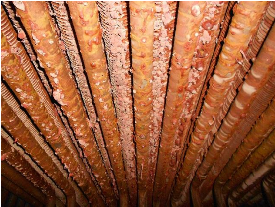
Abbildung 105 - Verdampferbündel 2
