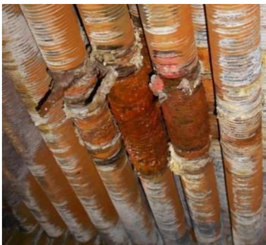
Abbildung 9 - Leckage Fernwärmeschleife
