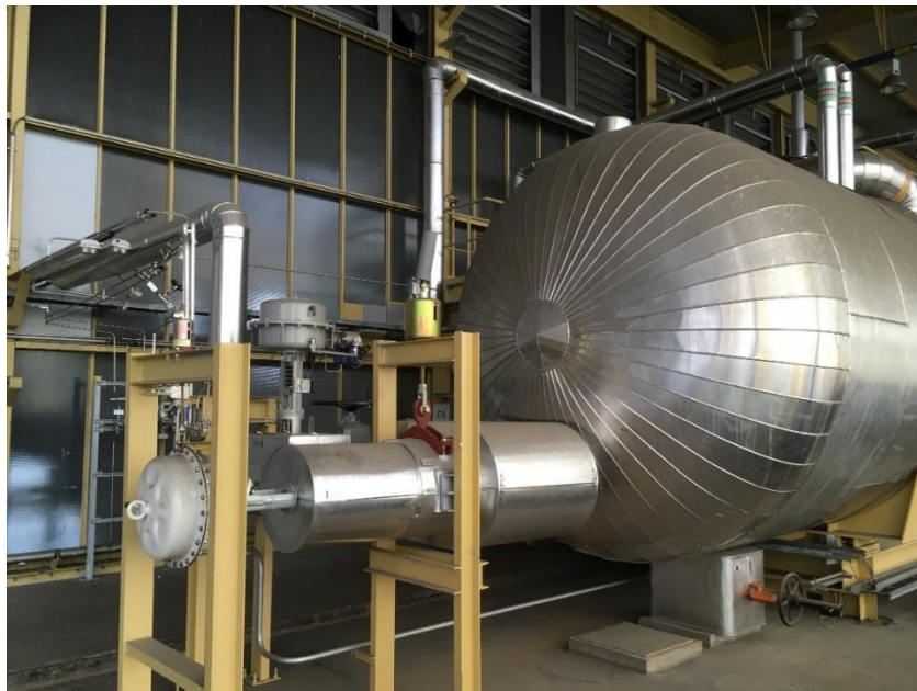
Abbildung 151 - ECO-Wasser-Bedampfung des Speisewasserbehälters
