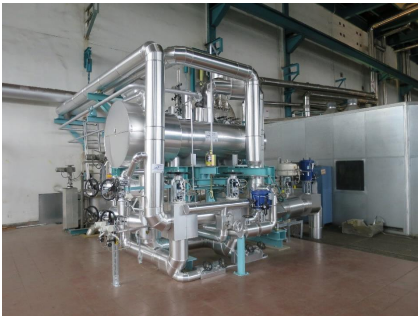
Abbildung 149 - HD-Vorwärmer
