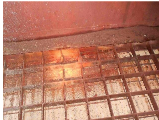
Abbildung 108 - lokaler Schaden Katalysator
