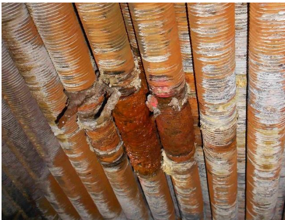
Abbildung 103 - Leckage Fernwärmeschleife
