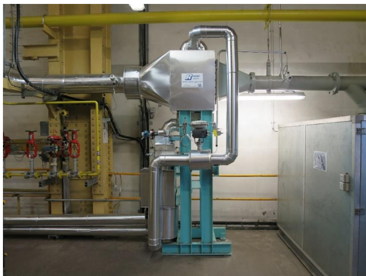
Abbildung 148 - Tragluftvorwärmer
