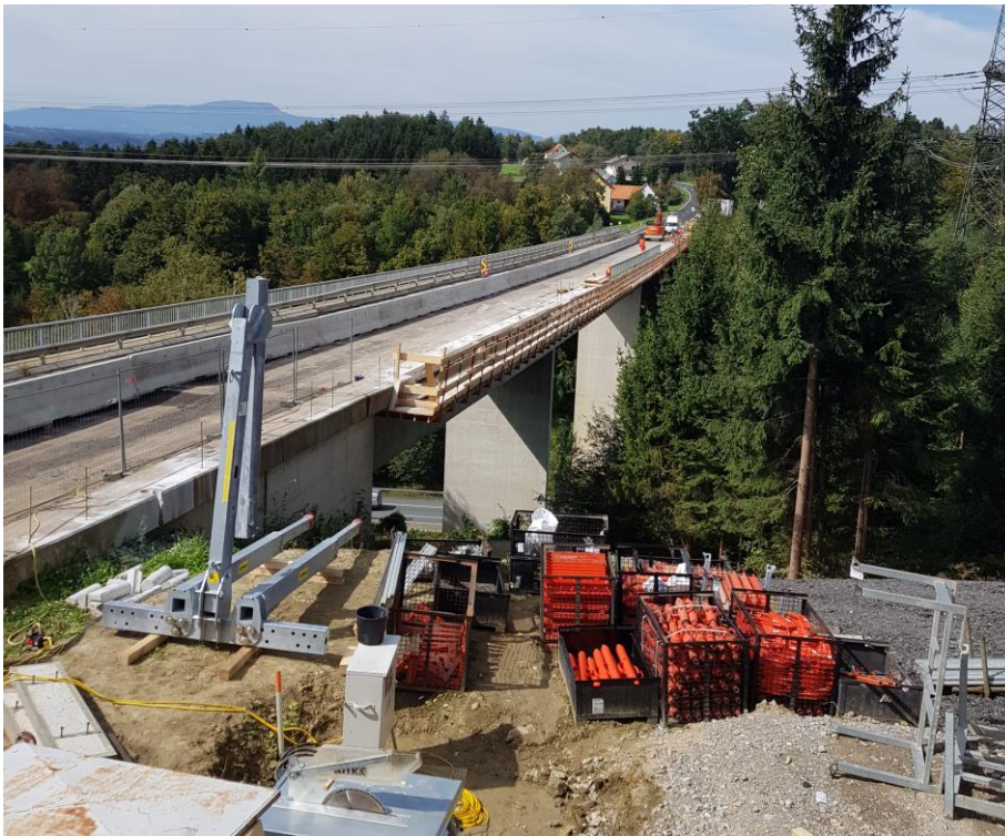
Abbildung 39 A2 + A9 Brückensanierung 248
