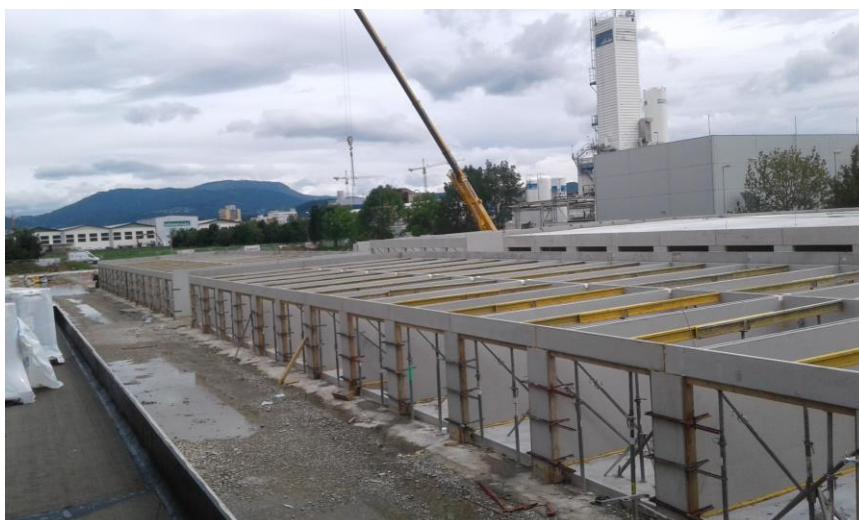
Abbildung 25 Ausführungsphase Green Storage 216
