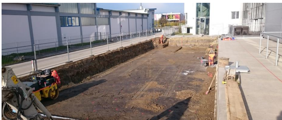
Abbildung 29 Ausführungsphase Bürobau Arian 224
