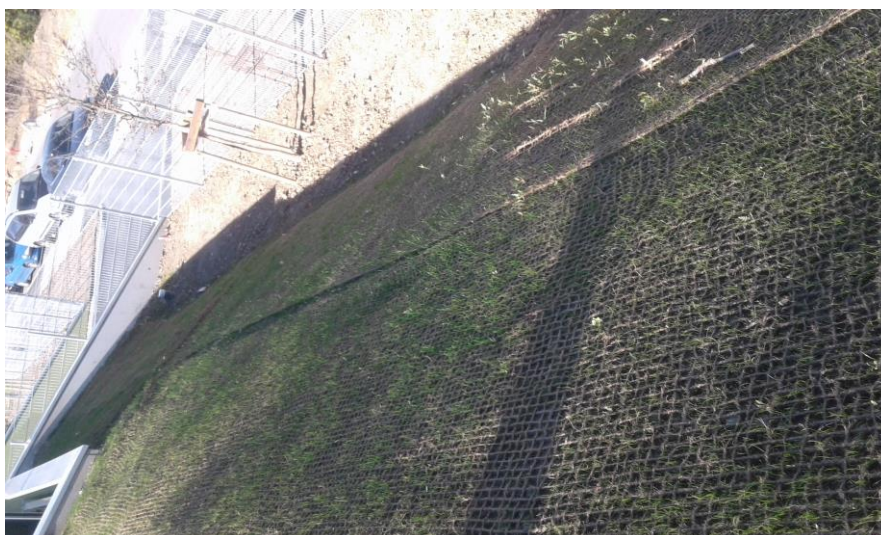
Abbildung 26 Begrünung Bauwerk mit Bambusmatten 218
