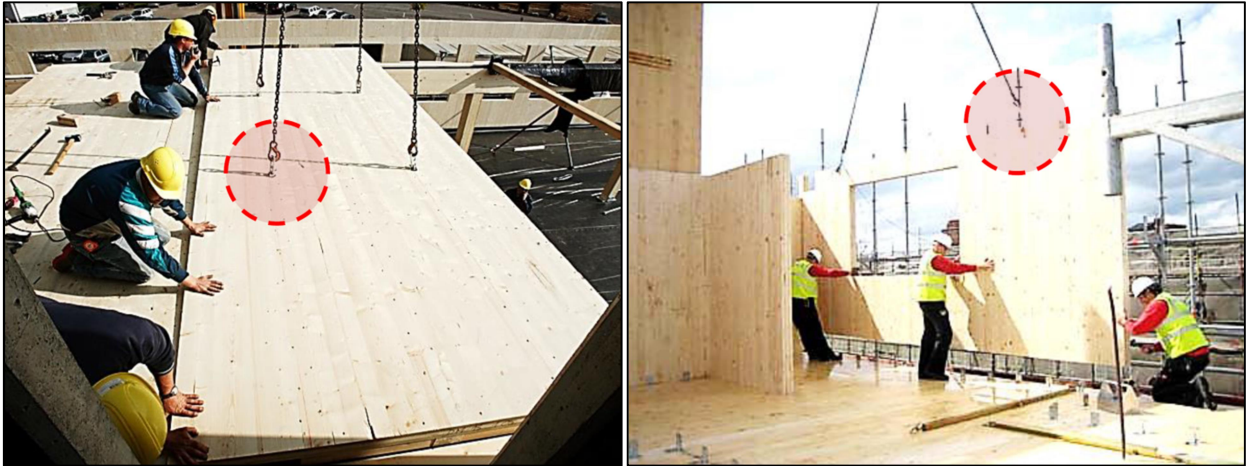
Abbildung 2-7: Montage Decke (links); Montage Wand (rechts) (Brandner, et al., 2018a)
