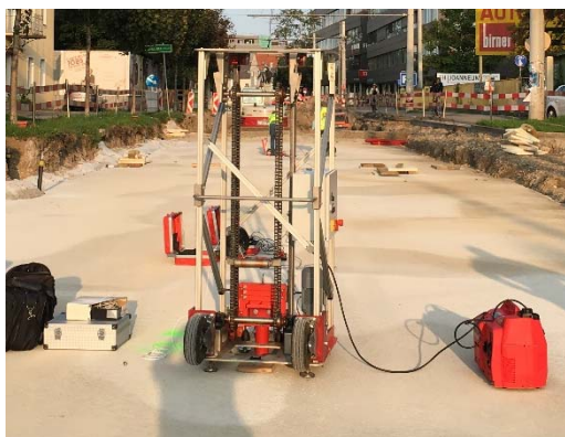
Abbildung 5-2: Fallgewicht aufgestellt auf einer Impedanzplatte (Quelle: tappauf.consultants)
