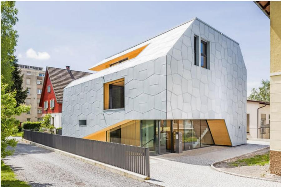
Abbildung 35: Vorgehängte hinterlüftete Fassade<sup>139</sup>
