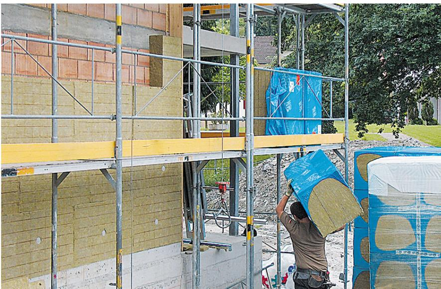
**Abbildung 70: Wärmedämmung mit Mineralwolle<sup>202</sup>**
