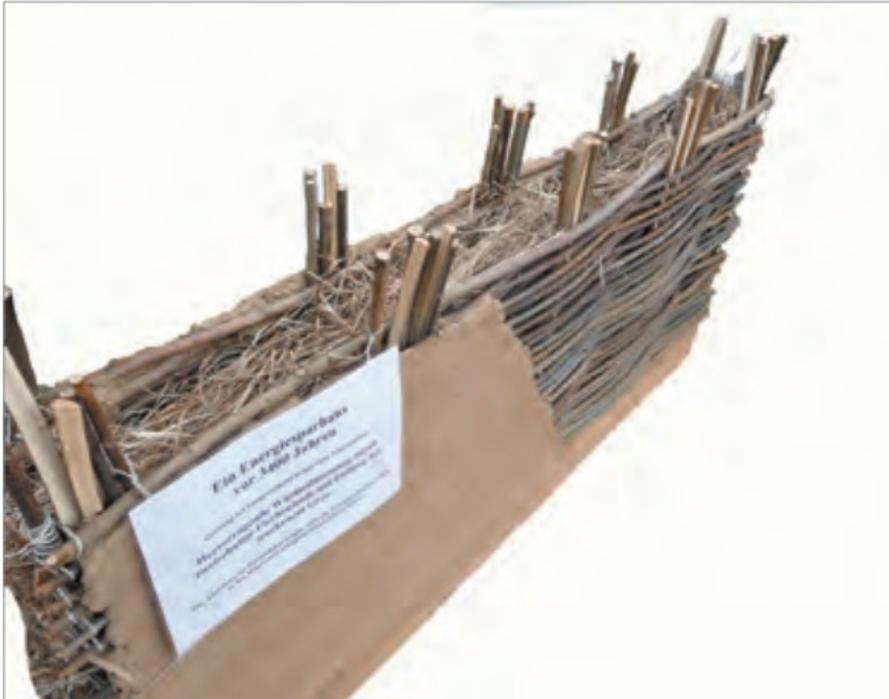
**Abbildung 1: Nachbau einer Flechtwand<sup>3</sup>**
