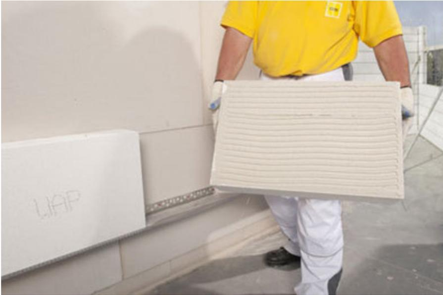
Abbildung 71: Wärmedämmung mit Mineralschaumplatte<sup>207</sup>
