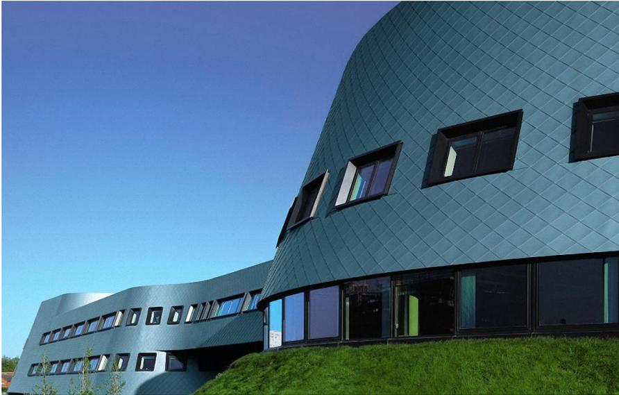
Abbildung 103: Aluminiumbekleidung<sup>278</sup>
