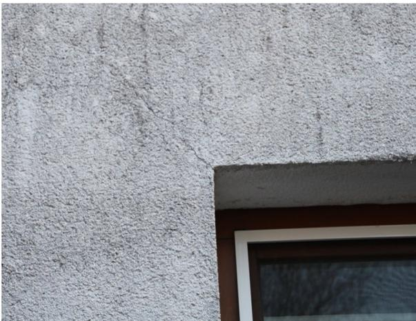
Abbildung 54: Riss infolge fehlender Diagonalbewehrung<sup>170</sup>
