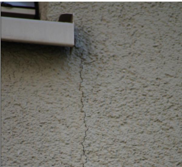
Abbildung 58: Riss entlang Dämmplattenstoß<sup>175</sup>
