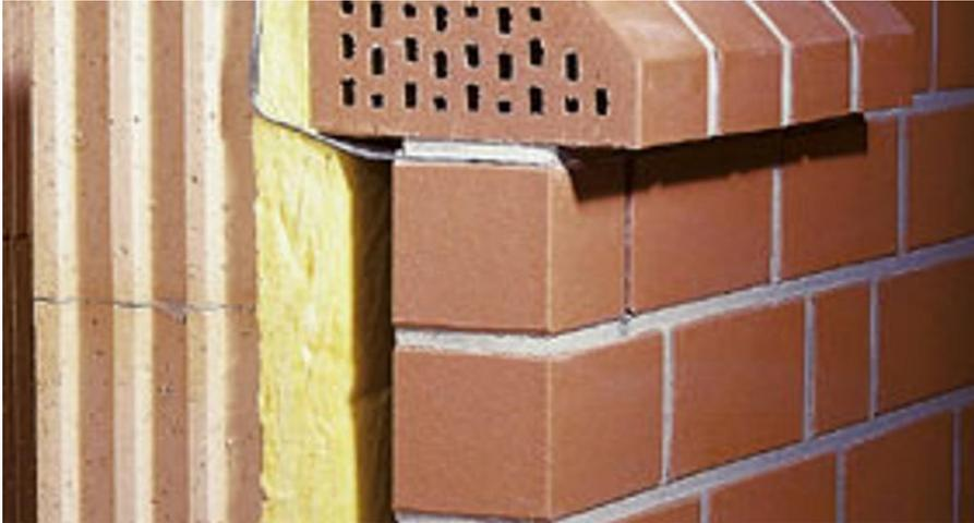
Abbildung 33: Zweischaliges Mauerwerk<sup>136</sup>
