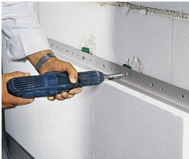
Abbildung 46: Tragschiene<sup>159</sup>
