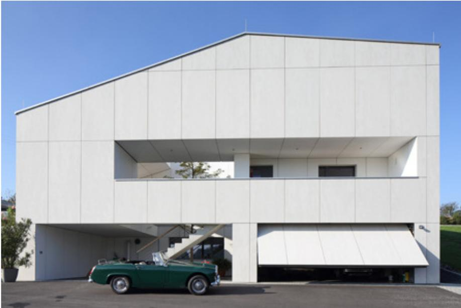
Abbildung 105: Faserzementbekleidung<sup>280</sup>
