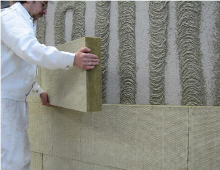
Abbildung 40: Maschinelle Verklebung<sup>150</sup>
