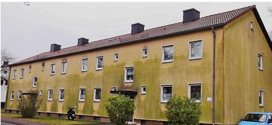
Abbildung 64: Fortgeschrittener Algenbewuchs an WDVS-EPS<sup>186</sup>
