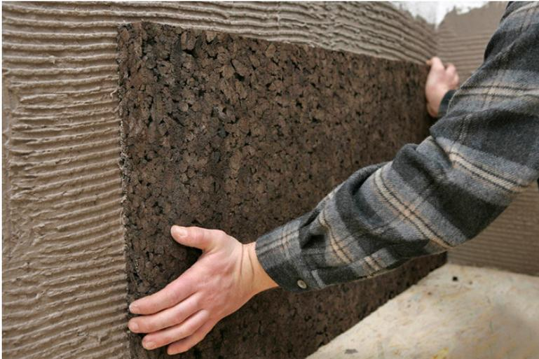
Abbildung 73: Korkdämmplatte<sup>213</sup>
