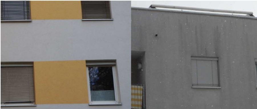
Abbildung 63: links WDVS-MW, recht WDVS-EPS<sup>185</sup>
