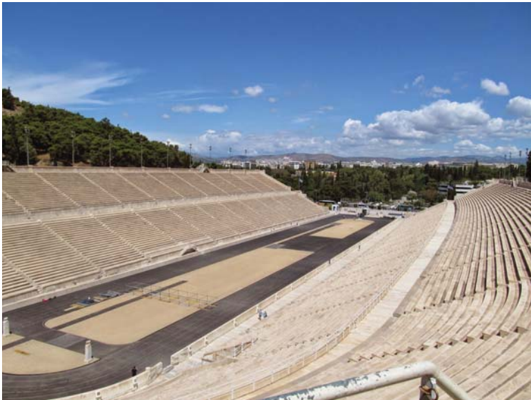
Abb.:42/43 Typisches U-Form Stadion. Restauriertes Olympiastadion in Athen von 1896.
