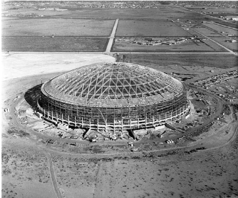
Abb.:29 Astrodome Houston im Bau (1954)
