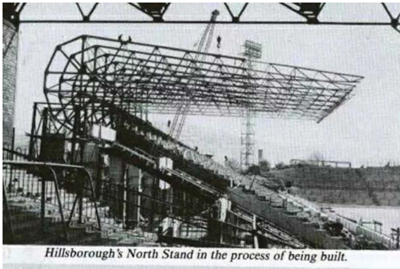
Abb.:28 Erste Vollüberdachung in England ohne Stützenkonstruktion (1961)
