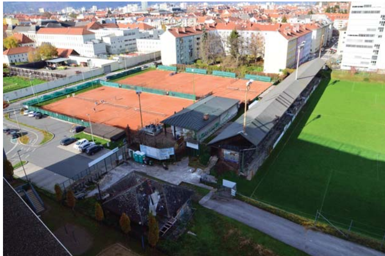
Abb.:86 Alte Westtribüne / Zufahrt Klosterwiesgasse-Jakominigürtel vom Dach Messequartier Richtung Norden
