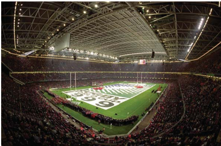
Abb.:34 Millennium Stadion mit öffenbarer Dachkonstruktion (1999)
