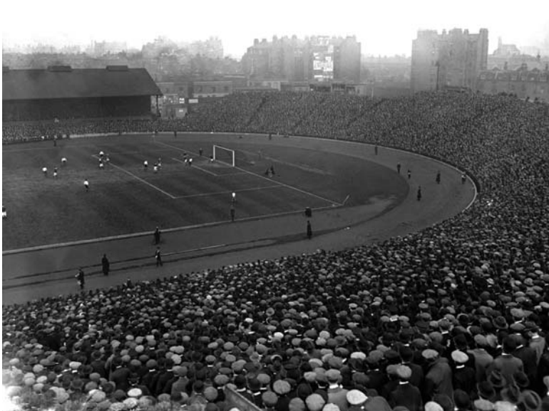
Abb.:50 ‚Stamford Bridge‘ London mit Laufbahn
