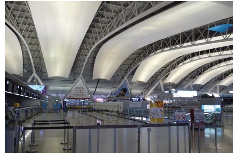
Abb.:119 Schalterhalle Innen
