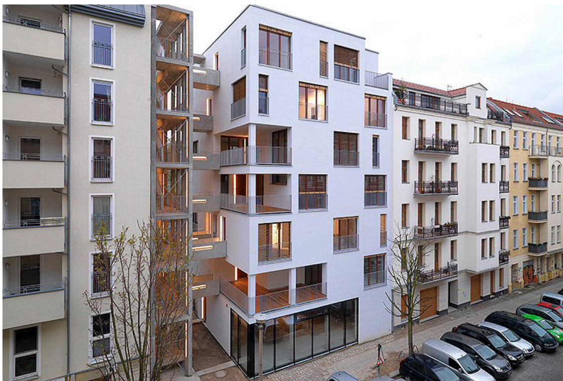
Abbildung 9 7-geschossiger Holzbau in Berlin (Kaden Klingbeil Architekten)
