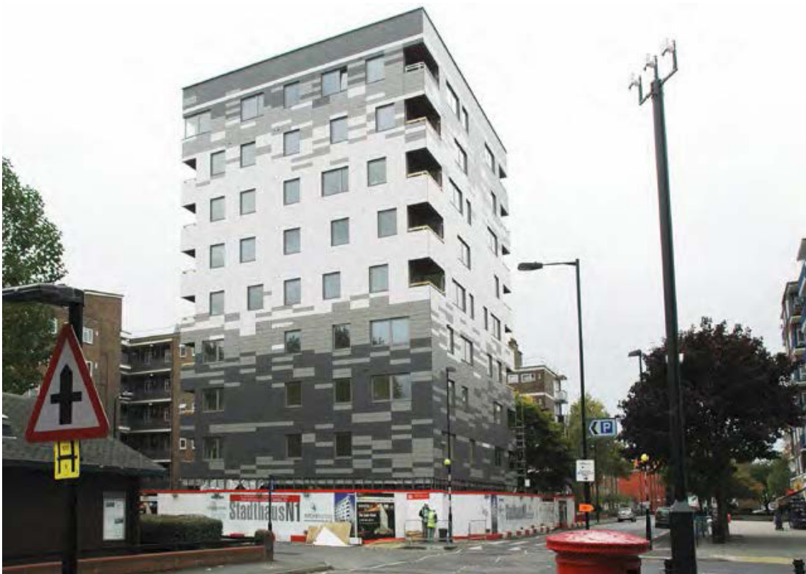
Abbildung 10 9-geschossiger Holzbau in London (Waugh Thistelton Architects)
