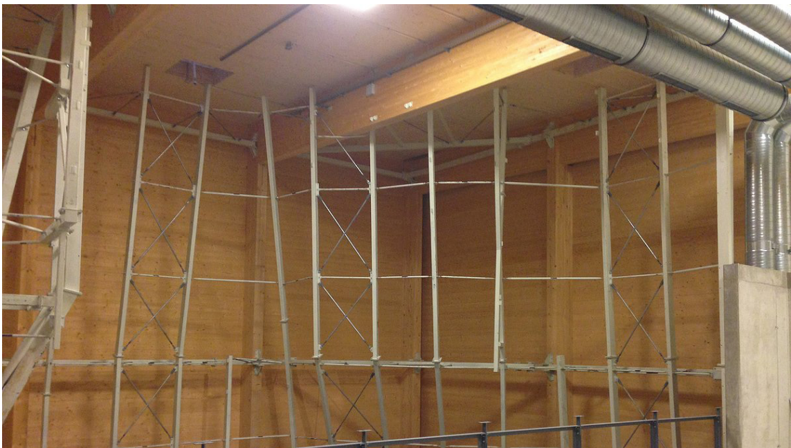
Abbildung 8 Unterkonstruktion aus Aluminium
