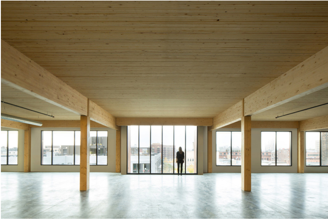
Abbildung 14 Beispiel 1 Skelettbau
