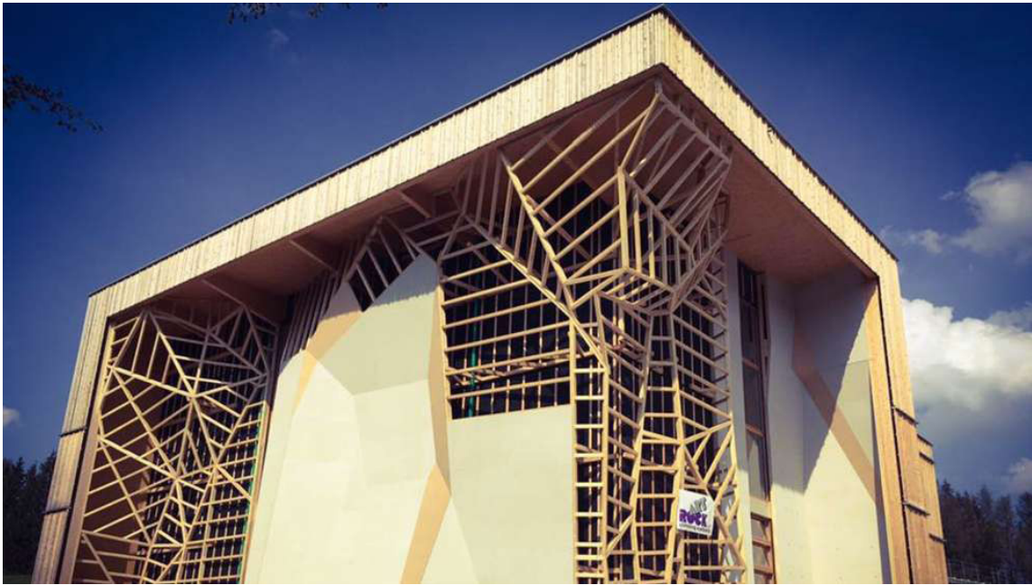
Abbildung 7 Unterkonstruktion aus Holz
