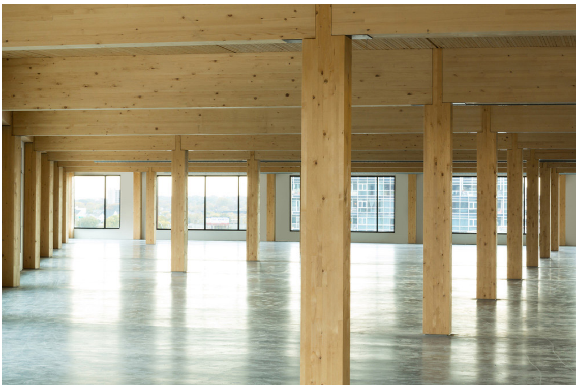
Abbildung 15 Beispiel 2 Skelettbau
