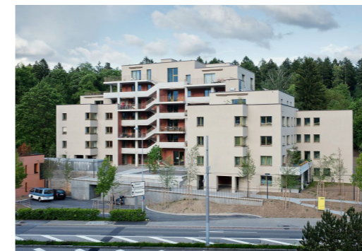
Abb. 18 Kraftwerk 2 mit Terrasse Commune
