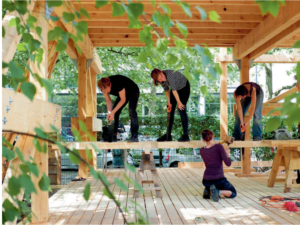
Abb. 35 Errichtung der Laube in Selbstbauweise
