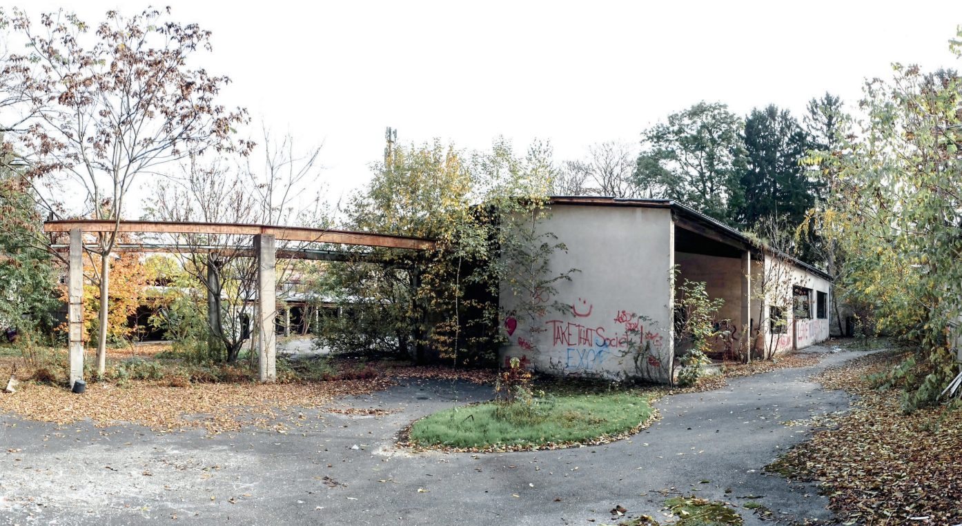
RECHTS IM BILD DIE PROJEKTIERTE INDUSTRIEHALLE MIT DEN CHARAKTERISTISCHEN STAHLTRÄGERN DER EHEM. TRAMBAHN
