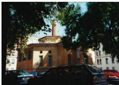
Abb. 50: Der Zustand des "Tröpfelbades" in Friedrichgasse 41 vor der Umgestaltung Architekturzentrum Wien, Sammlung, Foto: Margherita Spiluttini
