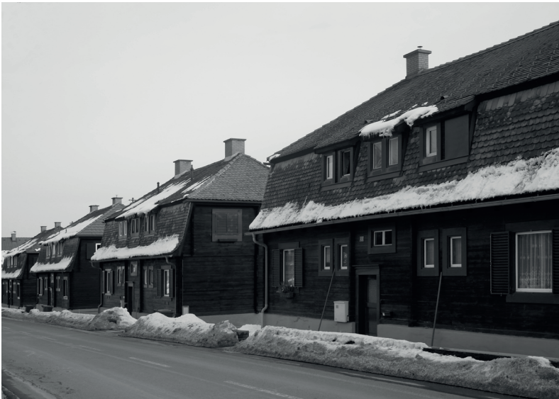
Abb. 39: Bilweis, Blockhäuser in der Landstraße, 2018
