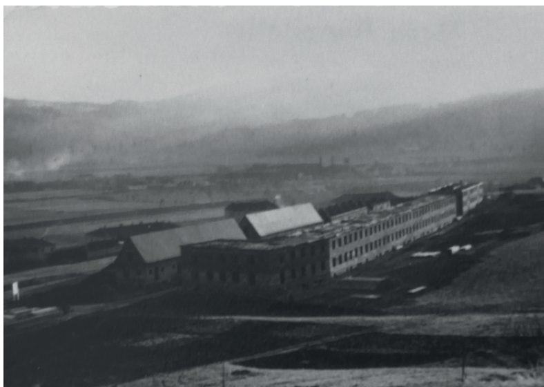
Abb. 51: Anonym, Auerling-Siedlung in der Bauphase von Nord-Osten betrachtet, o.J.
