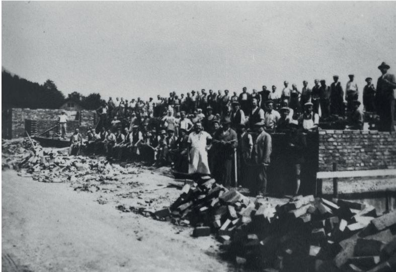
Abb. 49: Anonym, Auerling-Siedlung während der Bauphase, o.J.
