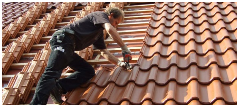
Abb.25: Dachziegel Montage
