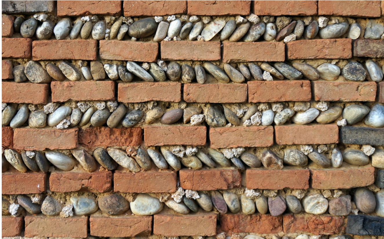
ABB. 15 SCHICHTMAUERWERK
