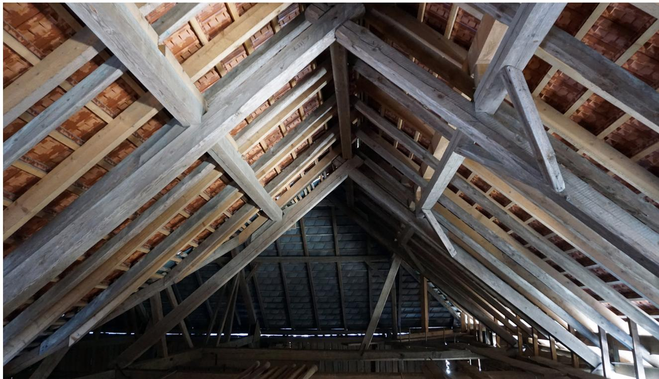
ABB. 51 VERSTÄRKTER DACHSTUHL
