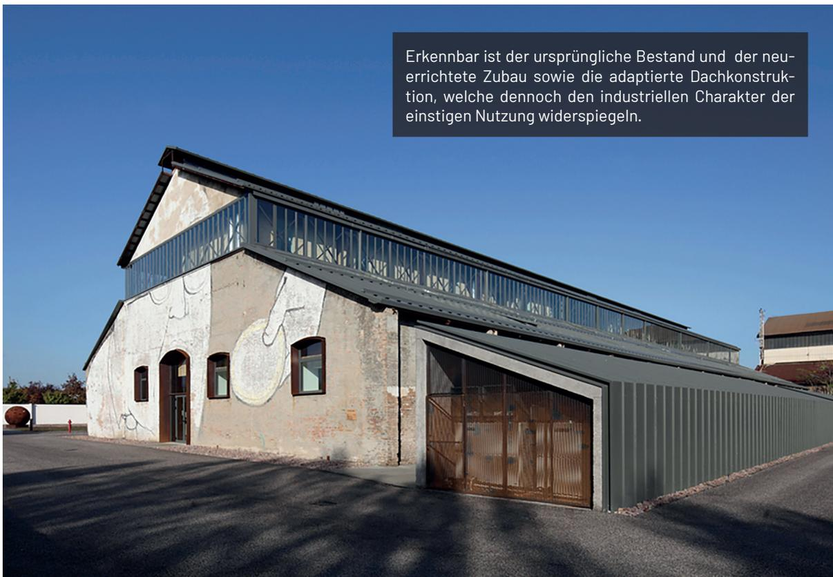
Erkennbar ist der ursprüngliche Bestand und der neuerrichtete Zubau sowie die adaptierte Dachkonstruktion, welche dennoch den industriellen Charakter der einstigen Nutzung widerspiegeln.
