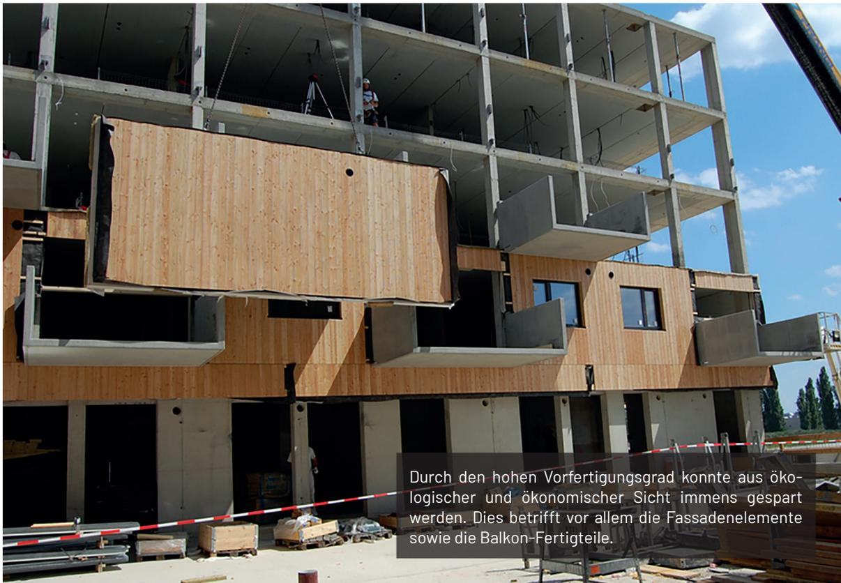
Abb. 114 Versetzen der vorgefertigten Elemente
