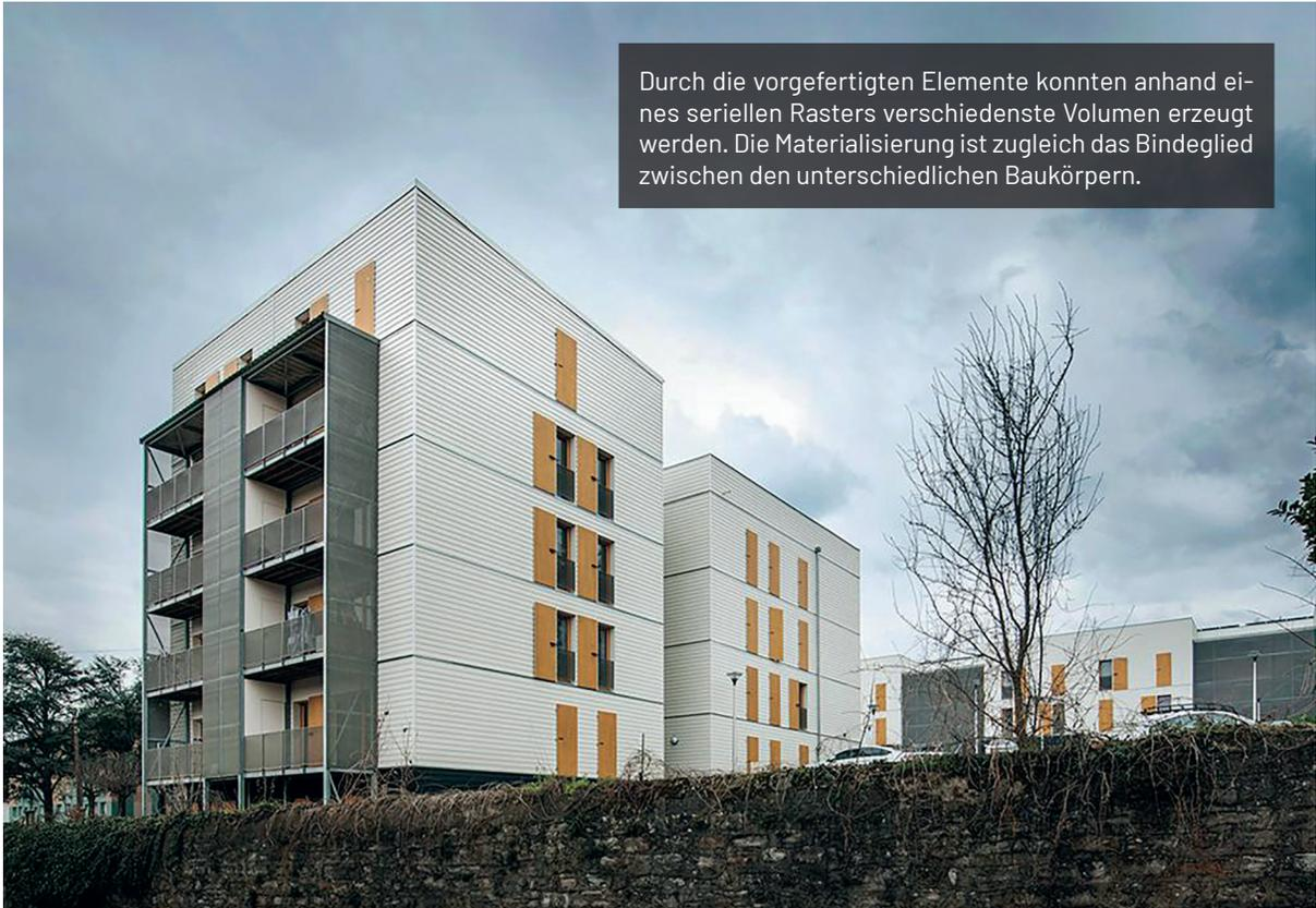
Durch die vorgefertigten Elemente konnten anhand eines seriellen Rasters verschiedenste Volumen erzeugt werden. Die Materialisierung ist zugleich das Bindeglied zwischen den unterschiedlichen Baukörpern.
