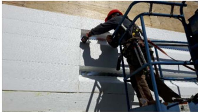
**Abbildung 8:** Befestigung der Dämmung an die Wand; Quelle: leqalett.ca
