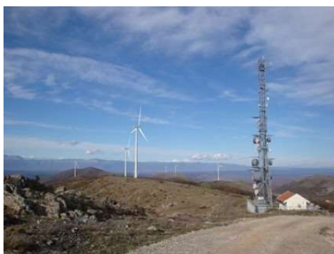
Figure 16: Zatriq location [NEK Umwelttechnik AG, 2010]
