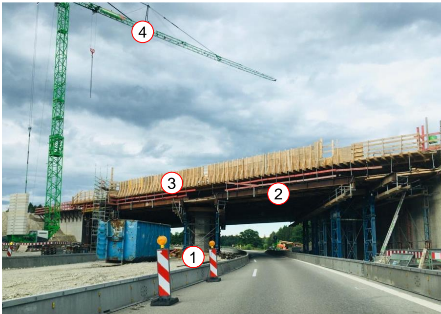
Abbildung 6-12 Sicherungsmaßnahmen bei Ingenieurbauarbeiten im Nahbereich von Straßen 269
