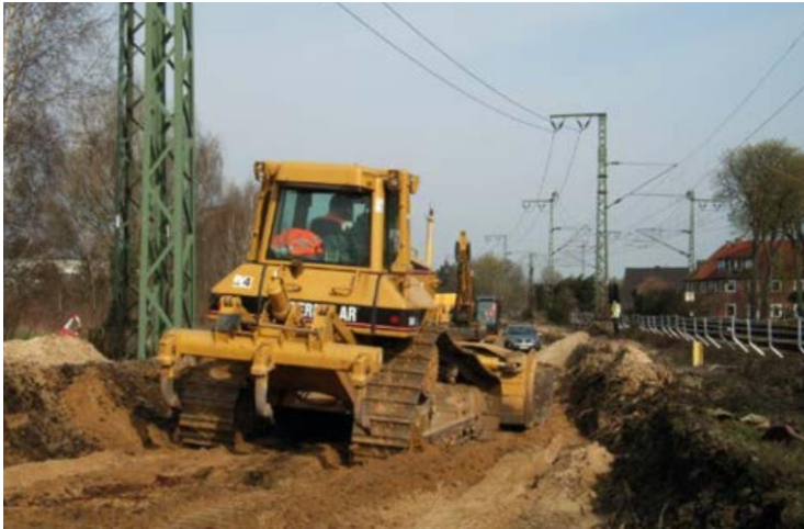
Abbildung 6-4 Erdbauarbeiten in Gleisnähe 237
