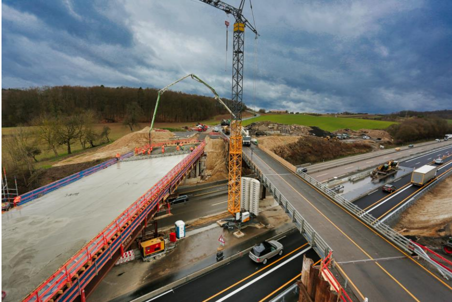
Abbildung 6-13 Turmdrehkran und Betonpumpe auf einer Autobahnbaustelle 273
