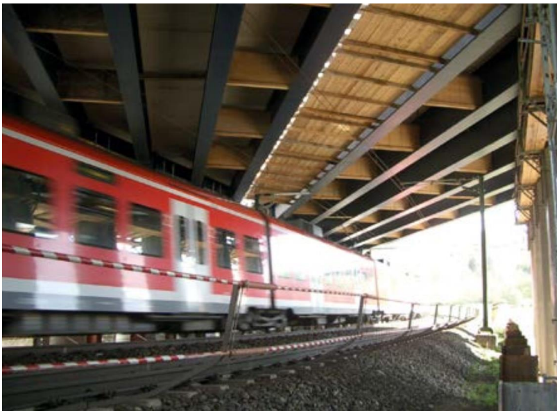
Abbildung 6-8 Lehrgerüst über Eisenbahnstrecke 250
