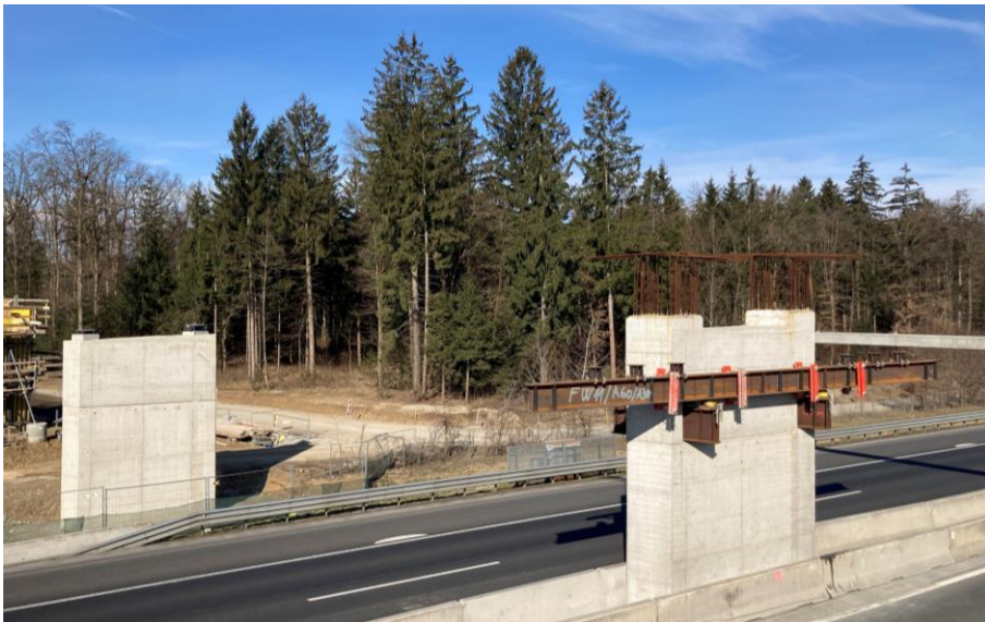
Abbildung 8-10 Durchsteckträger bei Mittelpfeiler zwischen Fahrbahnen 301
