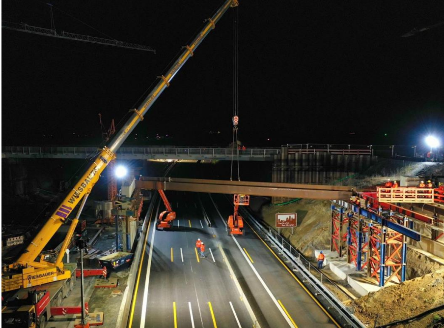
Abbildung 6-16 Errichtung Lehrgerüst während einer Totsperrung der Straße 277
