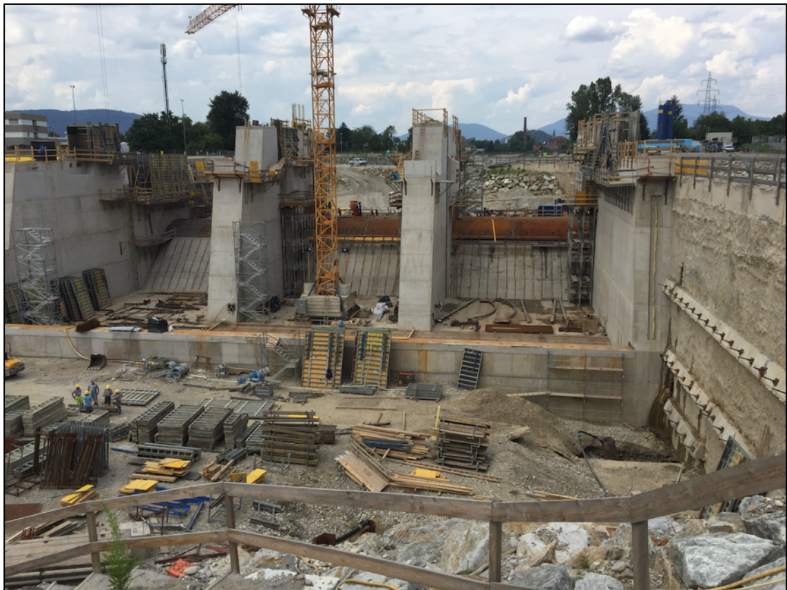
Abb. 40: Baustelle MKW Puntigam vom 05. Juli 2018, eigene Aufnahme
