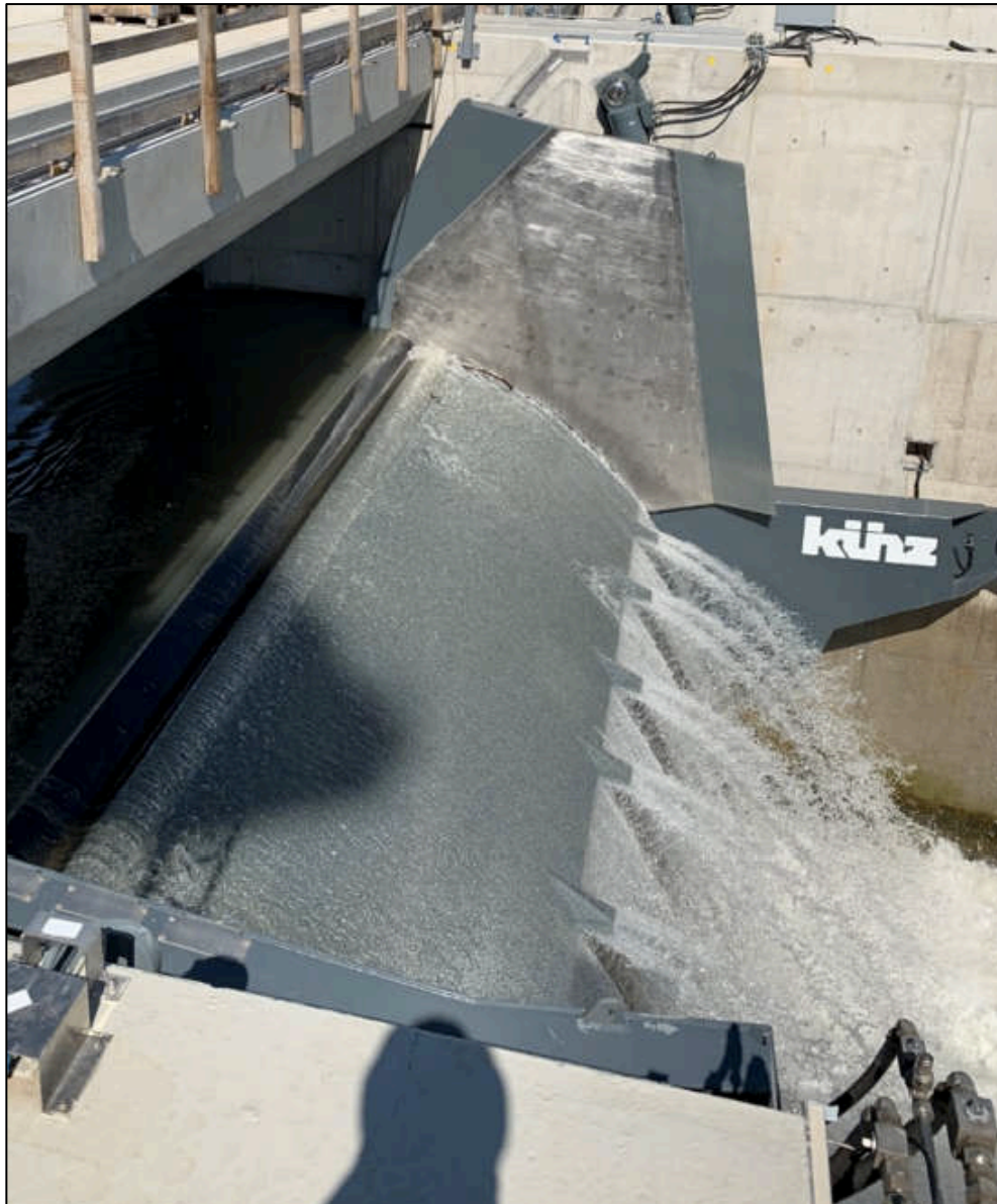
Abb. 52: Wehranlage mit umgelegter Klappe [65]
