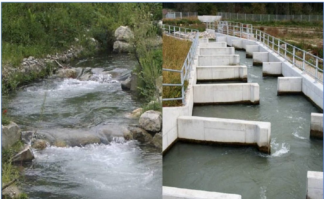
Abb. 57: Naturnaher Beckenpass (li.), Vertical-Slot-Schlitzpass (re.) [66]
