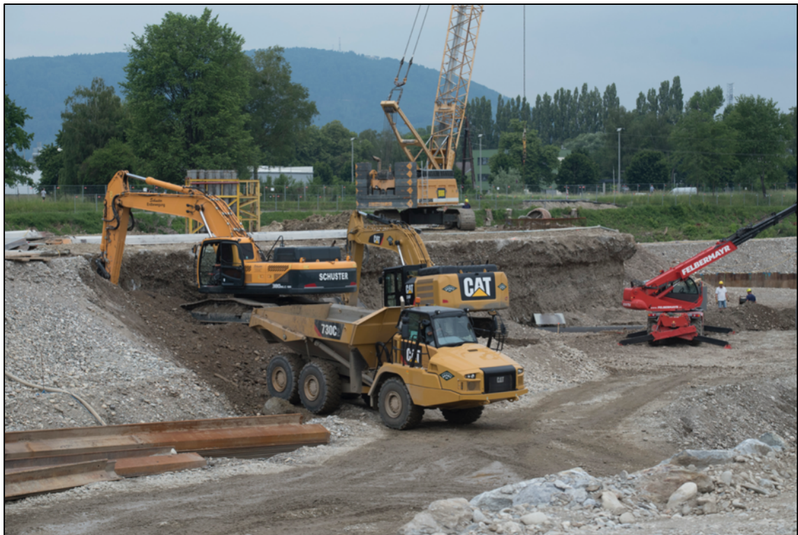
Abb. 37: Erdarbeiten MKW Puntigam vom 03. Juni 2017 [45]
