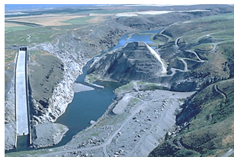
(h) Luftbild des zerstörten Damms
