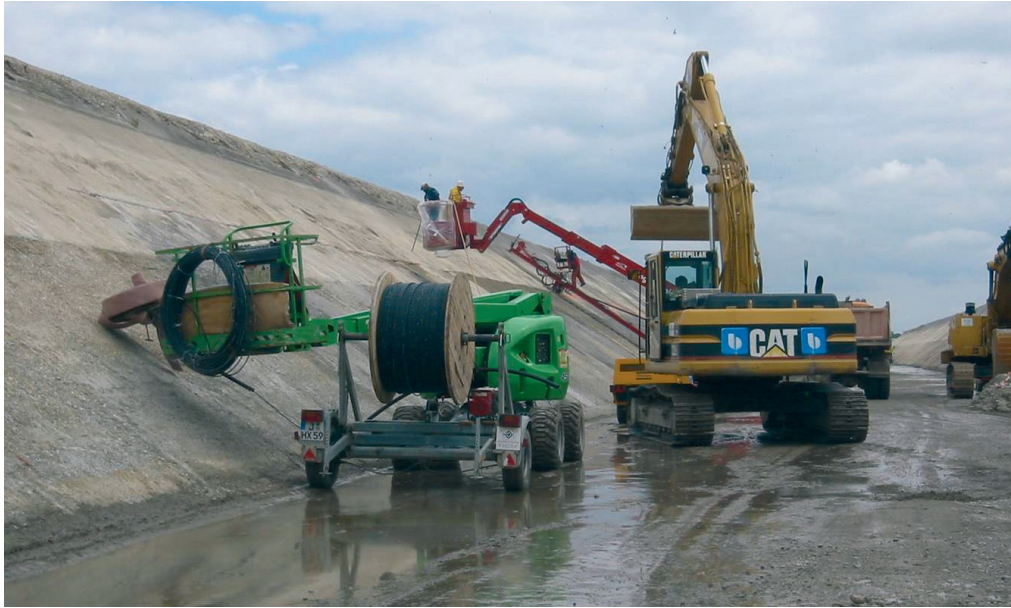
Abbildung 8.13: Verlegung der Glasfaserkabel (Isarkanal) [81]
