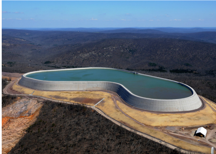
Abbildung 6.11: Taum Sauk Damm – neuer Damm [35]
