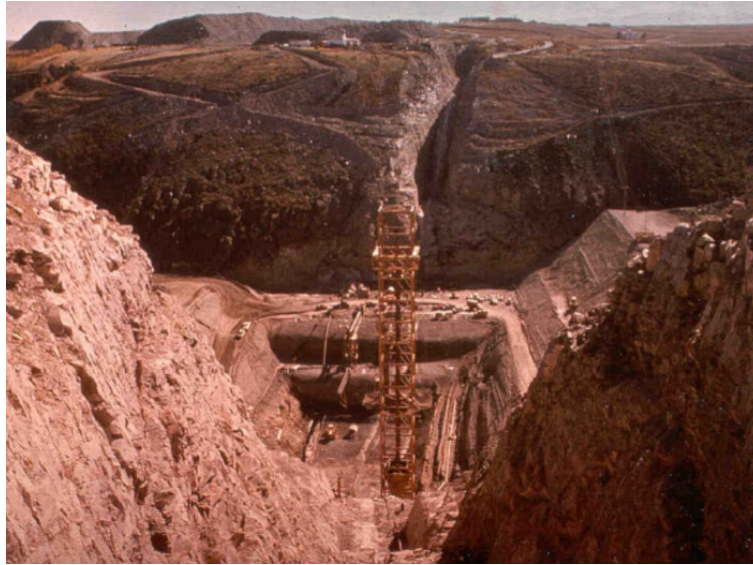
Abbildung 6.12: Blick vom linken zum rechten Widerlager während des Baus [38]
