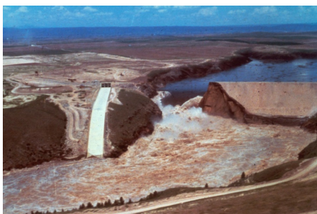
(g) Luftbild des Dammversagens mit Flutwelle
