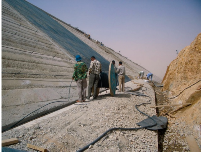
Abbildung 8.14: Verlegung des Kabels auf einer Betonoberflächendichtung (Merowe Dam am Nil, Sudan) [81]
