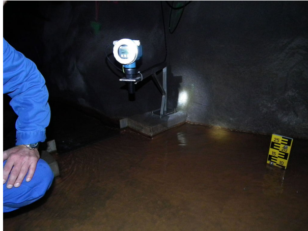
Abbildung 8.4: Pegelmessung: Ultraschall (links) und Lattenpegel (rechts) [73]
