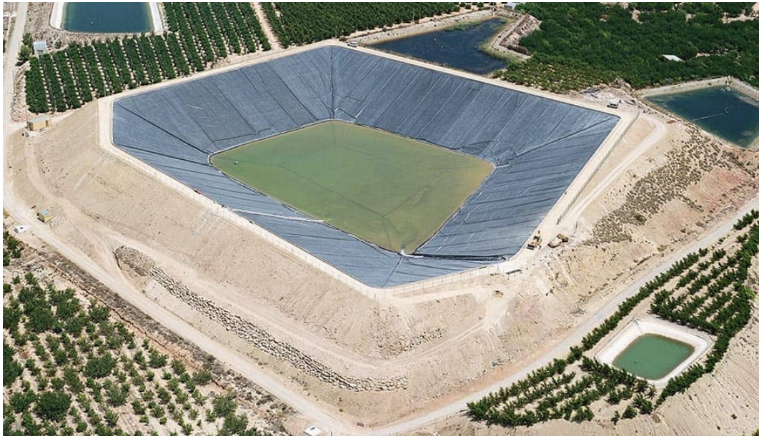
Abbildung 3.5: Dichtungsbahnen als Außendichtung [15]
