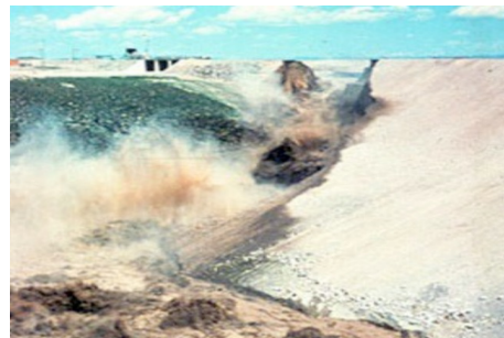
(f) 11:55 Uhr: Bruch des Teton Damms
