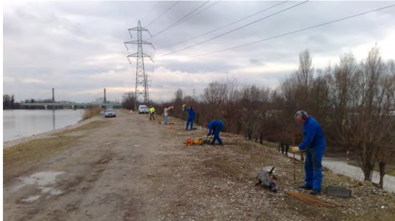
Abbildung 8.9: Einrammen der Temperaturmessgestänge [78]
