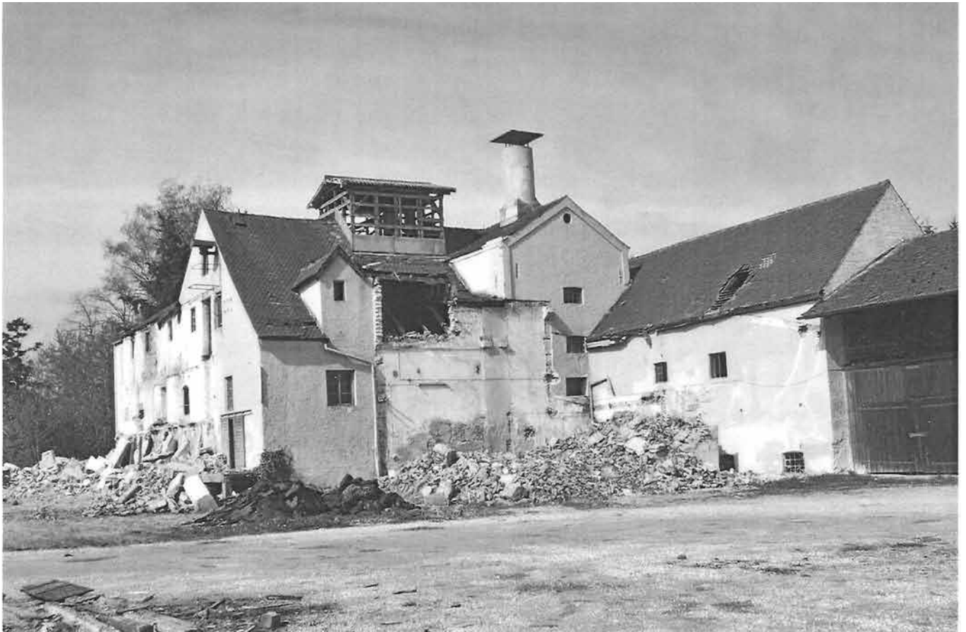
Abriss der Mälzerei 2006
