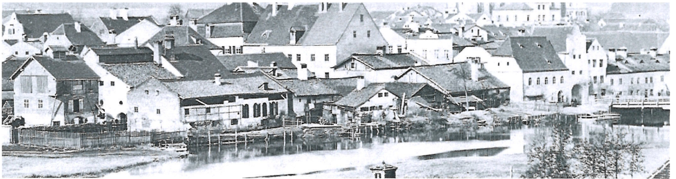
Blick auf das Brauereigelände (links) und das untere Stadttor (rechts) 1885
