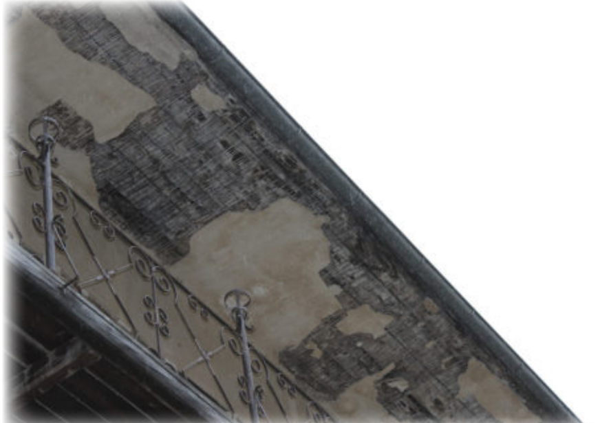
Abb. 49 C. Prenner, Burg Thalb., Thalberg, 2020, Dachunterseite
