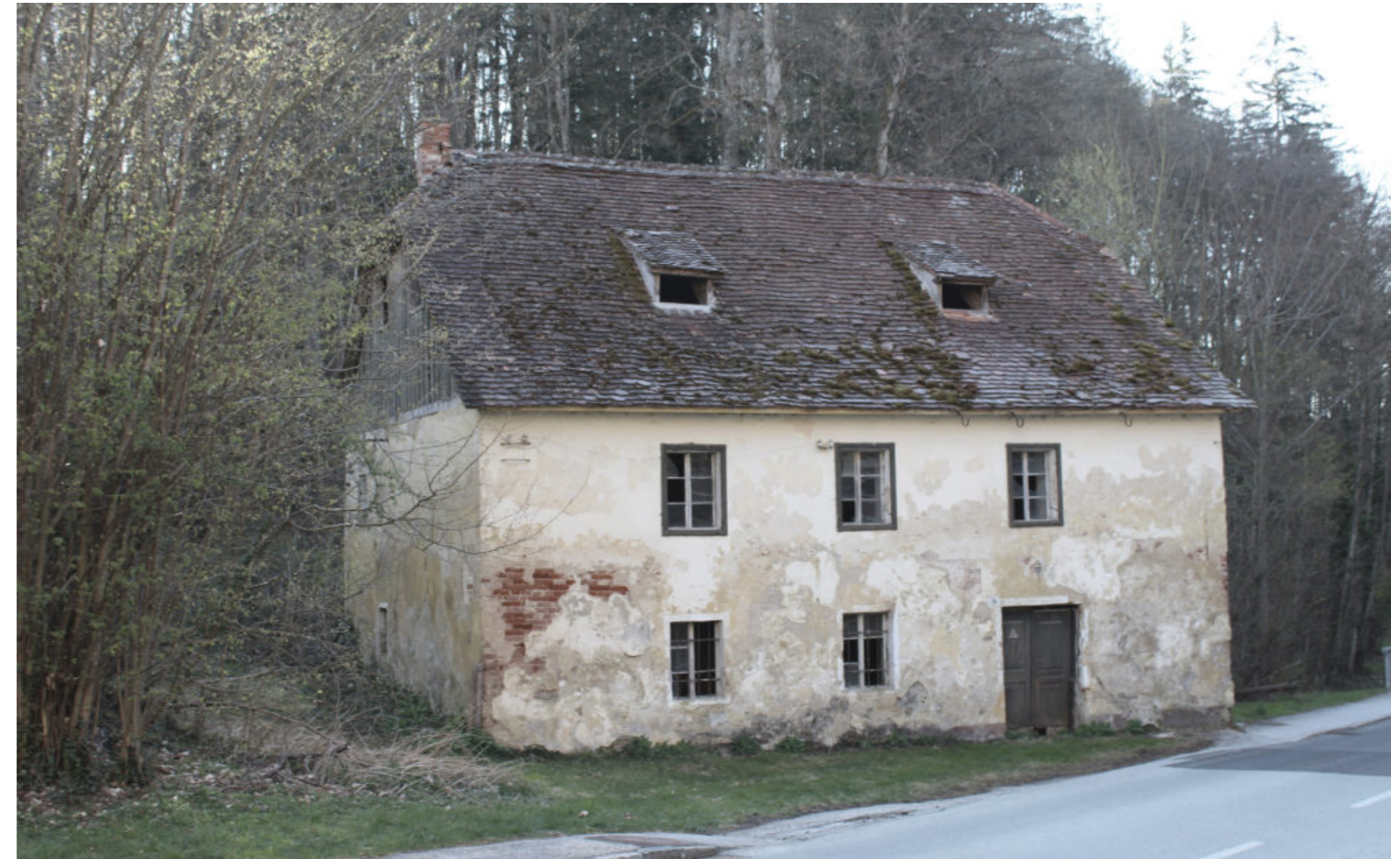
Abb. 20 C. Prenner, Burg Thalberg, Thalberg, 2021, Mühle
