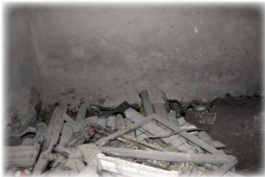
Abb. 48 C. Prenner, Burg Thalberg, Thalberg, 2020, Zisterne
