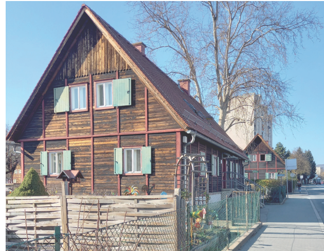
Abb. 53: Holzhaussiedlung Graz-Wetzelsdorf, Hauptstraße
