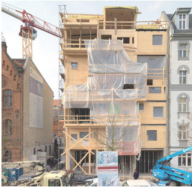
Abb. 46: Kaden Klingbeil Architekten, Mehrgeschossiger Holzbau E3 Berlin, Bau
