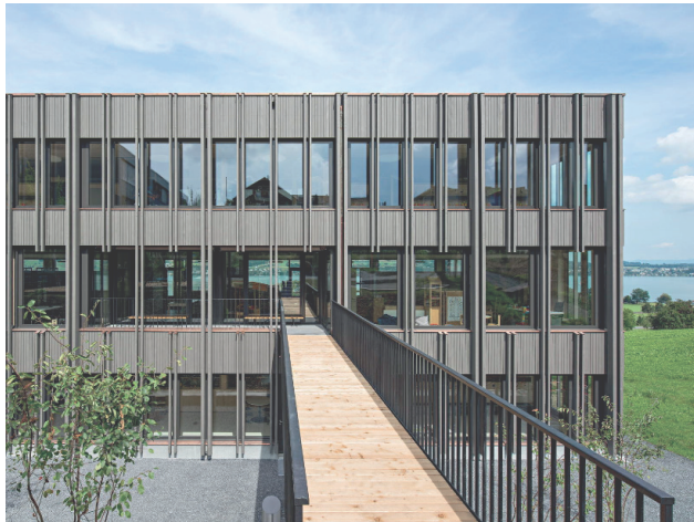
Abb. 12: Volksschule in Notwill Außenansicht
