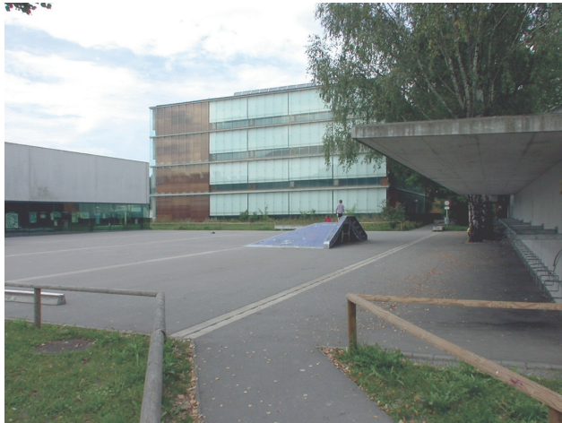
Abb. 15: Hauptschule Mäder Außenansicht
