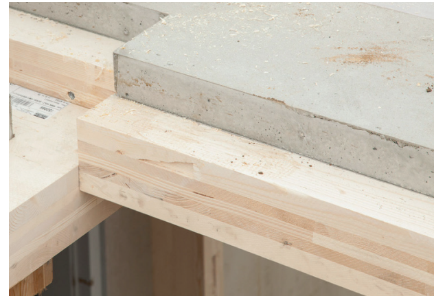
Abb. 55: Holzbetonverbunddecke
