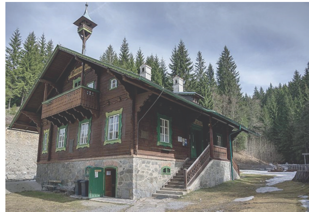
Abb.3: Waldschulhaus am Alpl
