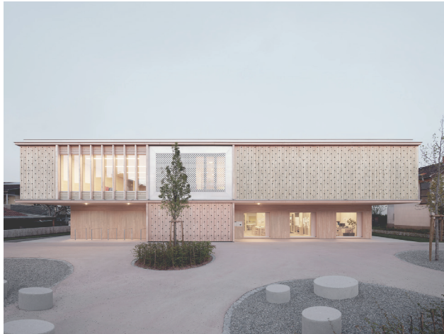
Abb. 62: Kindergarten am Engelbach Außenansicht
