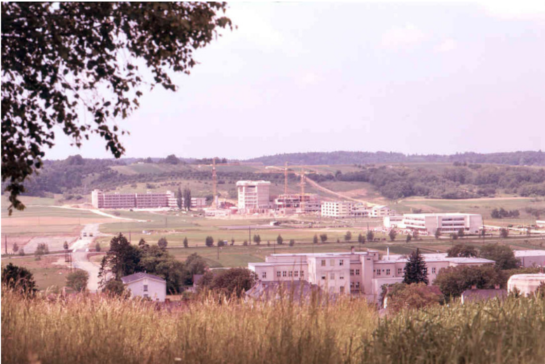
Bezirksstiftungskrankenhaus mit Baustelle im Hintergrund um 1978
