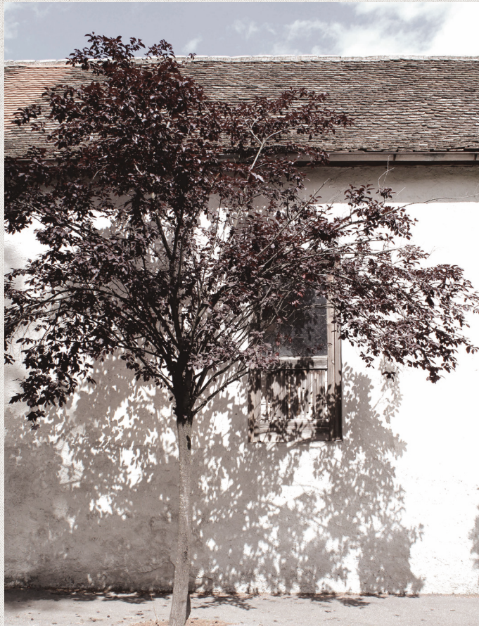
Ansicht West Zugang zum Obergeschoss
