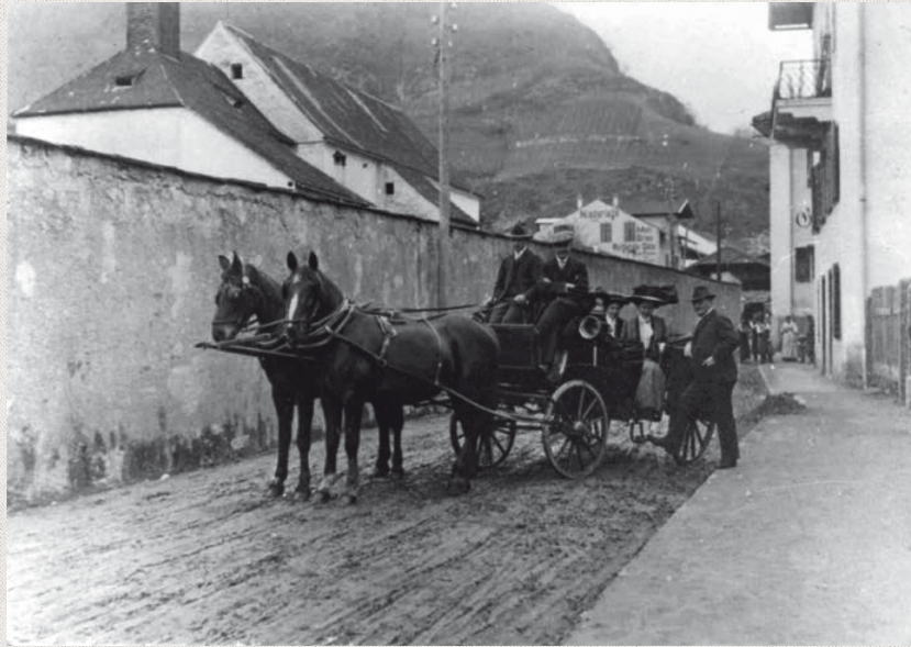
Abb. 49: Klostermauer entlang der Andreas-Hofer-Straße vor der Versetzung
