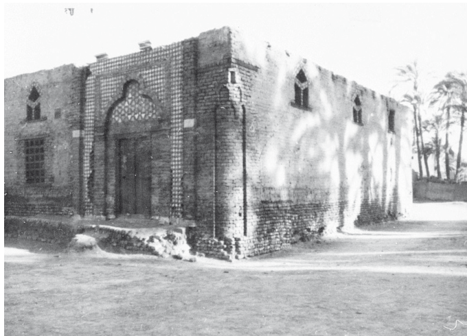
Abb. 03: Pachomius-Kloster, Umfassungsmauer mit Eingangstür
