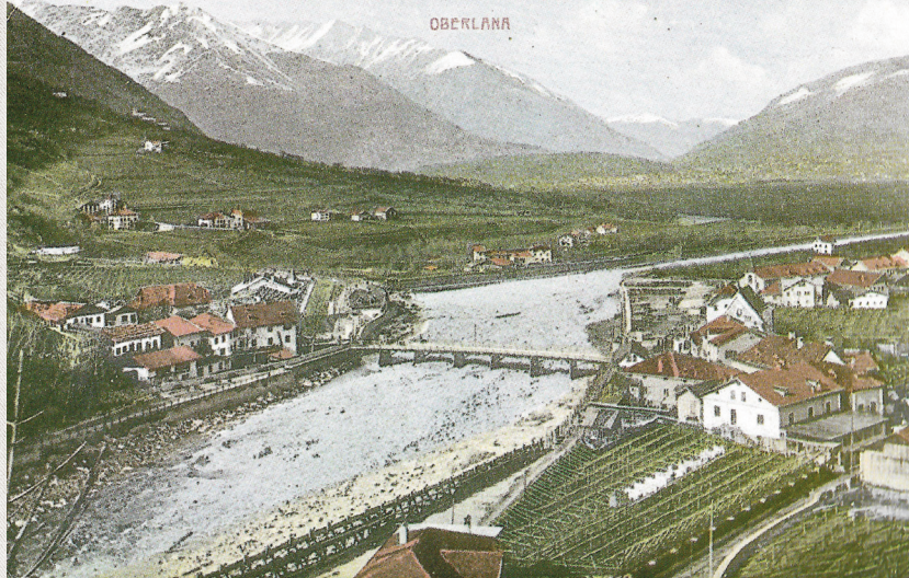
Abb. 42: Oberlana mit Falschauerbrücke
