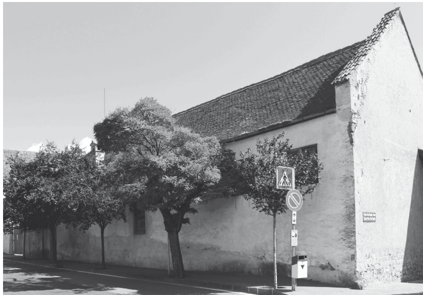
Ansicht West und Süd, Brandwand
