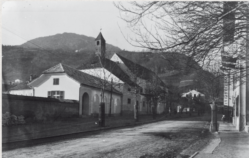
Abb. 50: Klostermauer entlang der Andreas-Hofer-Straße, Drittordenssaal
