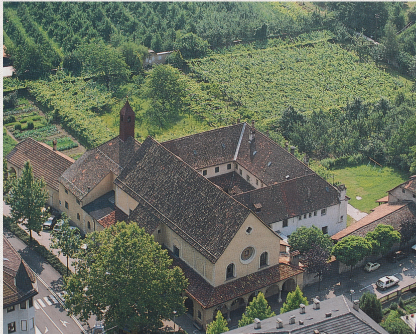
Abb. 48: Das Kapuzinerkloster vor dem Abbruch und Neubau des Drittordenssaals
