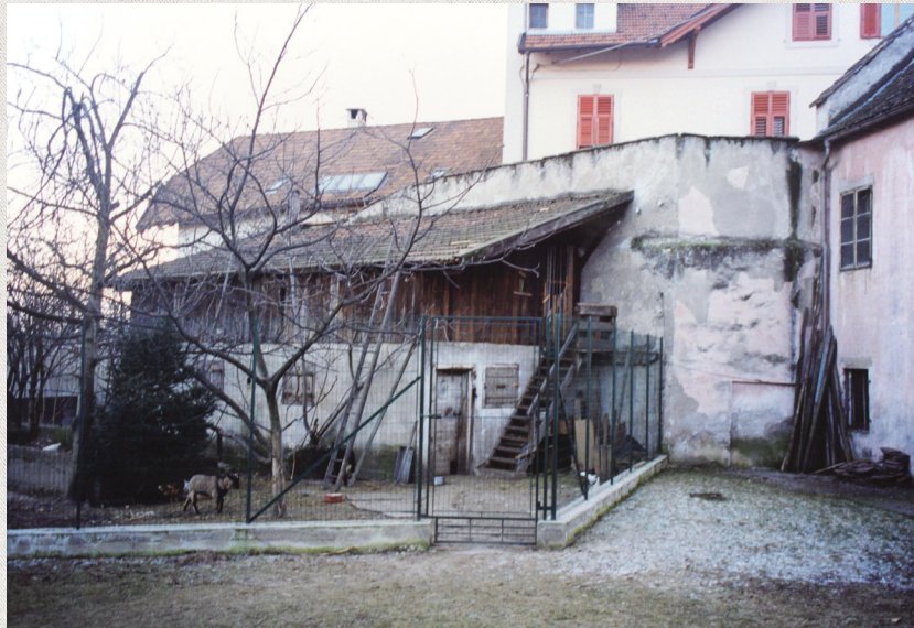
Abb. 56: Stall und Kleintiergehege vor der Weberei
