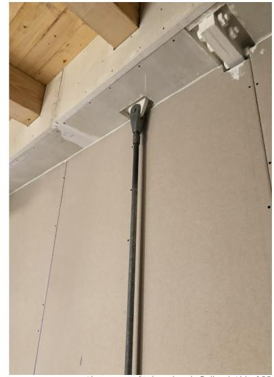
Abspannung für bestehende Balken | Abb. 103
