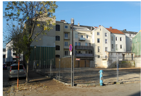
Abbildung 28: [c] - Foto vom Bauplatz
