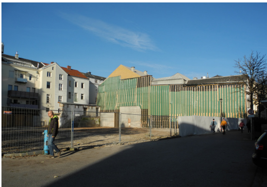
Abbildung 27: [b] - Foto vom Bauplatz
