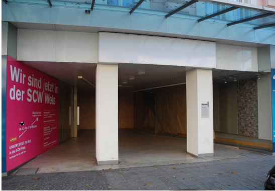
Abbildung 39: [l] - Zugang von der Ringstraße
