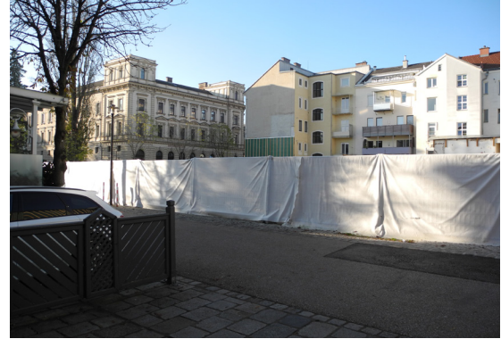
Abbildung 26: [a] - Foto vom Bauplatz
