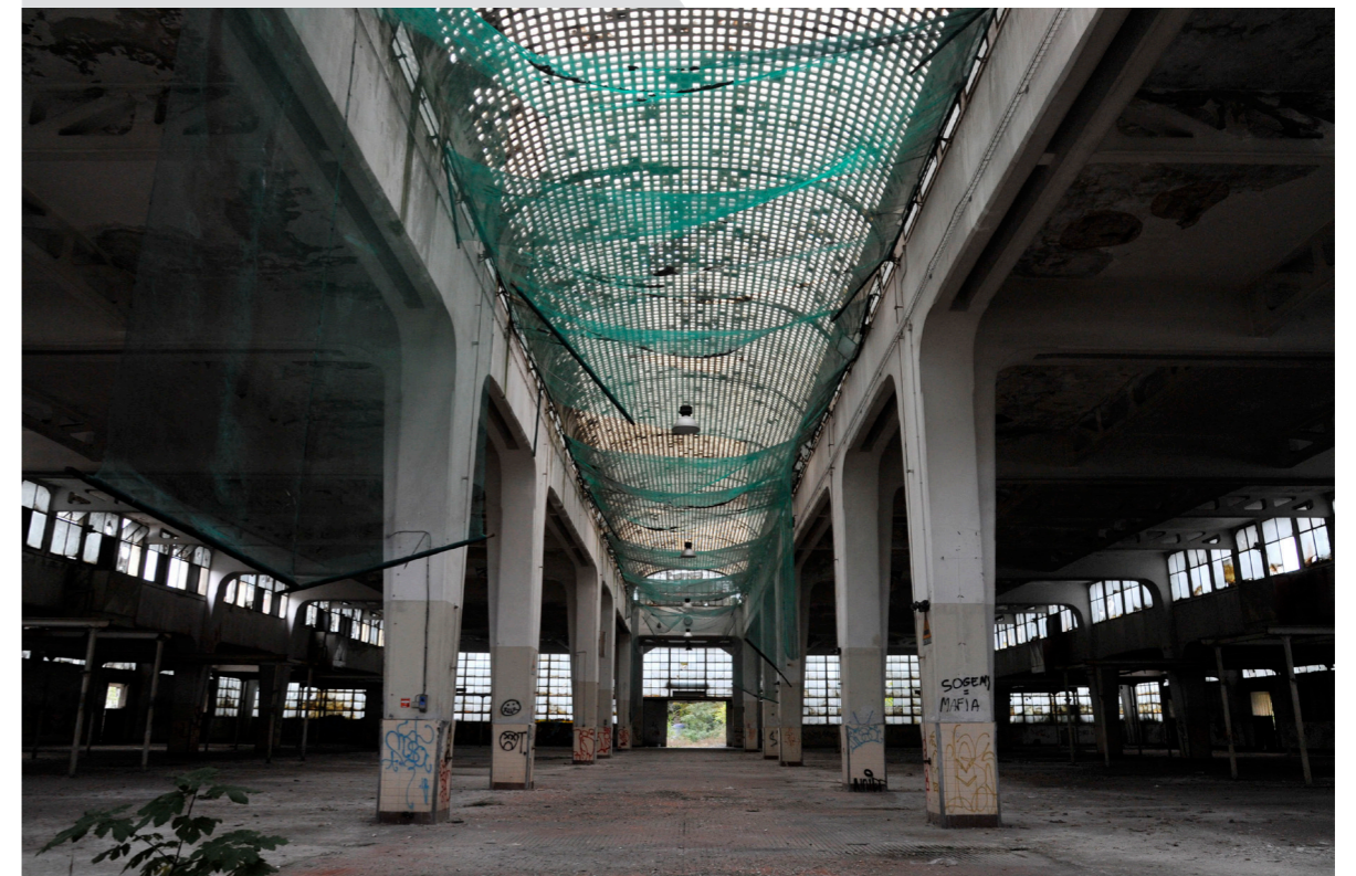
Oben: Vieh- und Markthalle während der mailänder Modewoche Unten: Ursprünglicher Zustand
