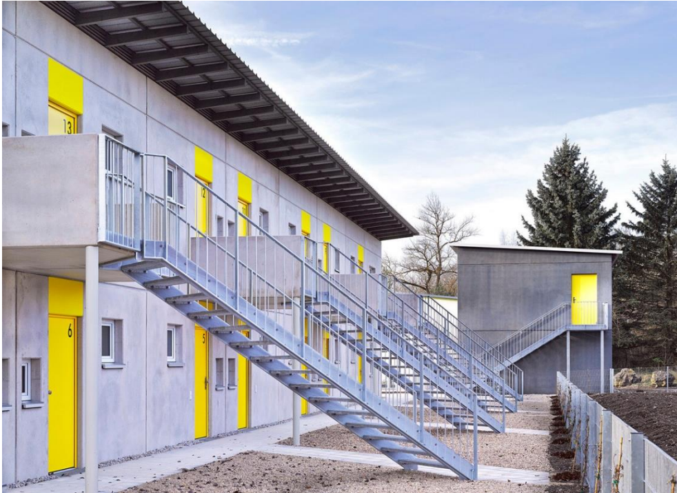
Abb.29: eap Architekten, Wohnanlage Am Franziskanerwasser, Ingolstadt, 2014, Zugänge Wohnungen
