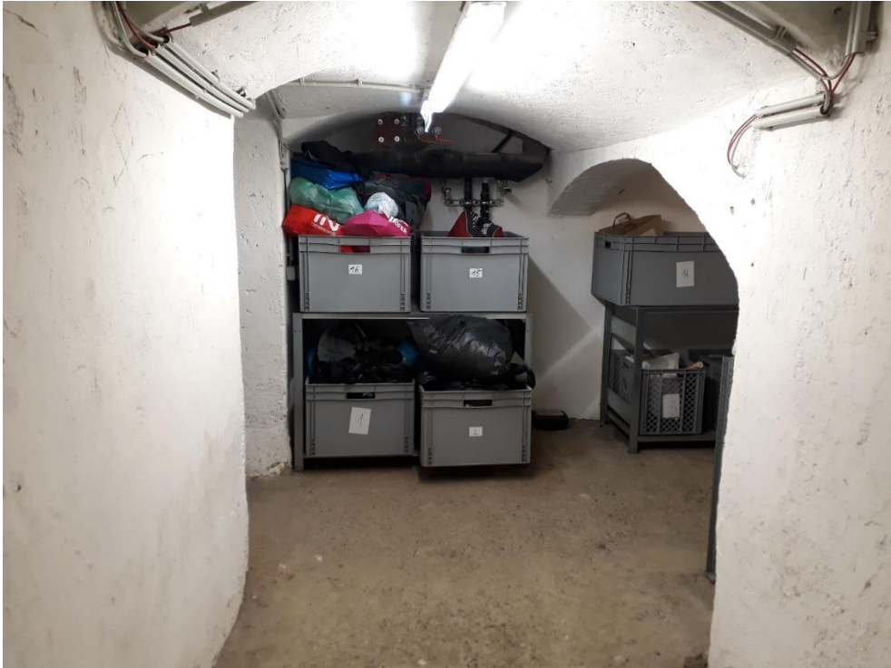
Abb.48: Arche 38, Graz, Lagerboxen Kellergeschoss
