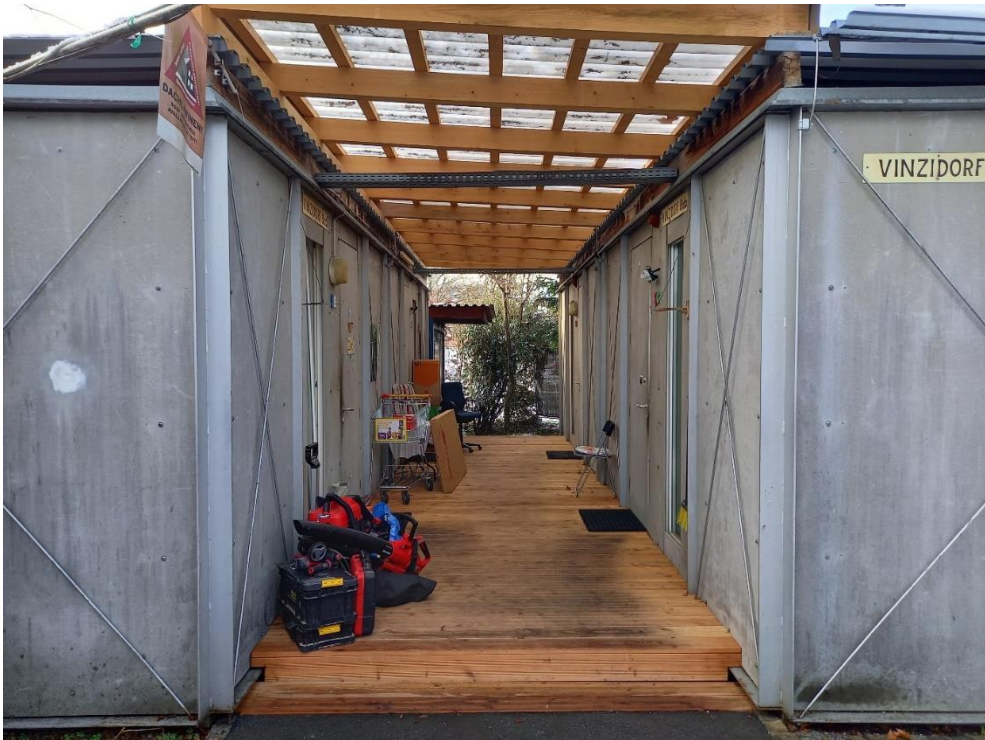
Abb.65: VinziDorf, Graz, Containerüberdachung
