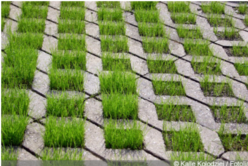
Abbildung 9: Beispiel einer oberirdischen Flächenversickerung mit Rasengittersteinen (Redaktion Gartendialog, 2014)
