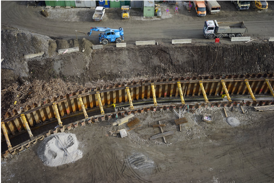
Abbildung 7: Zentraler Speicherkanal von Graz im Bauzustand (Holding Graz - Kommunale Dienstleistungen GmbH, 2020)
