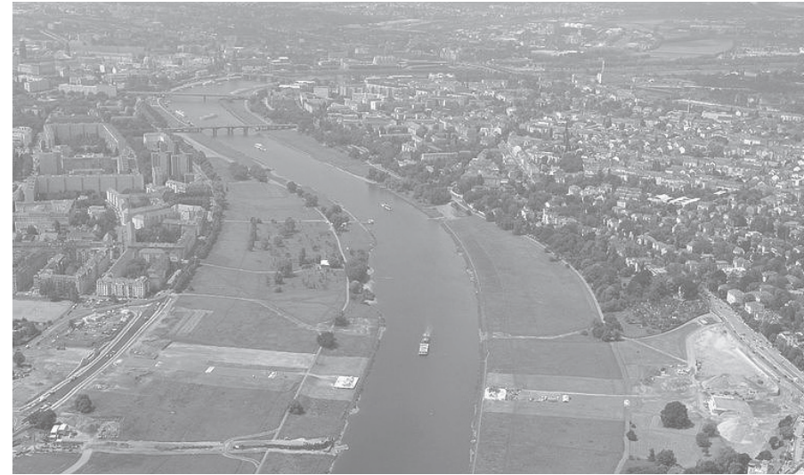
Abb.67.: Elbwiesen mit Waldschlösschenbrücke im Bau
