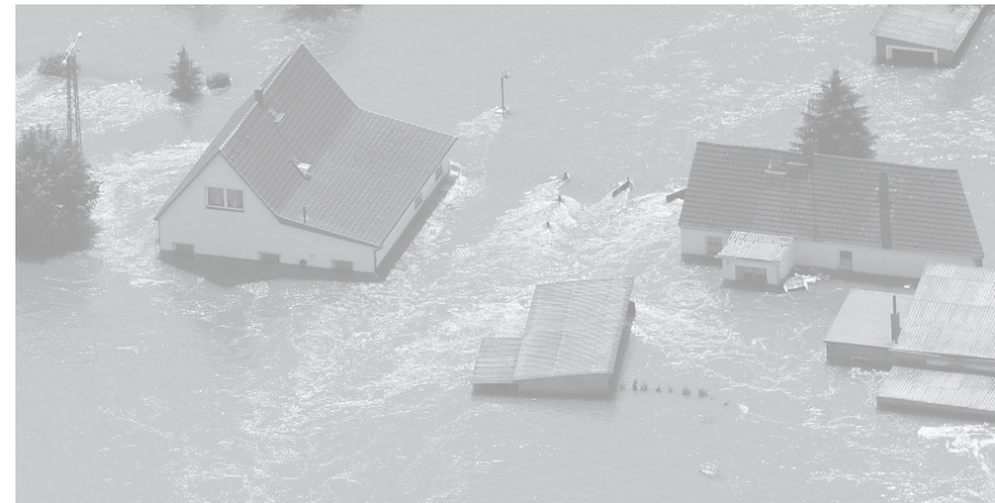
Abb.19.: Hochwasserschäden in Fischbeck 2013
