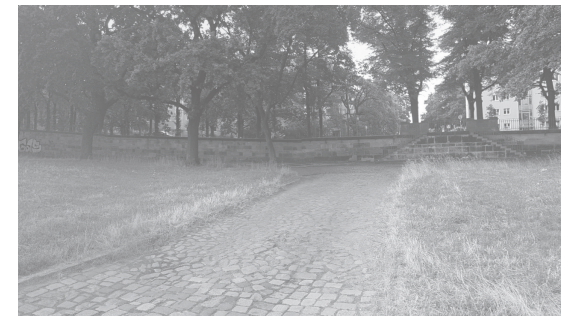
Abb.80.: aktueller Hochwasserschutz am Terrassenufer
