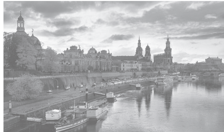
Abb.24.: Terrassenufer in der Innenstadt als Schutz gegen das Hochwasser
