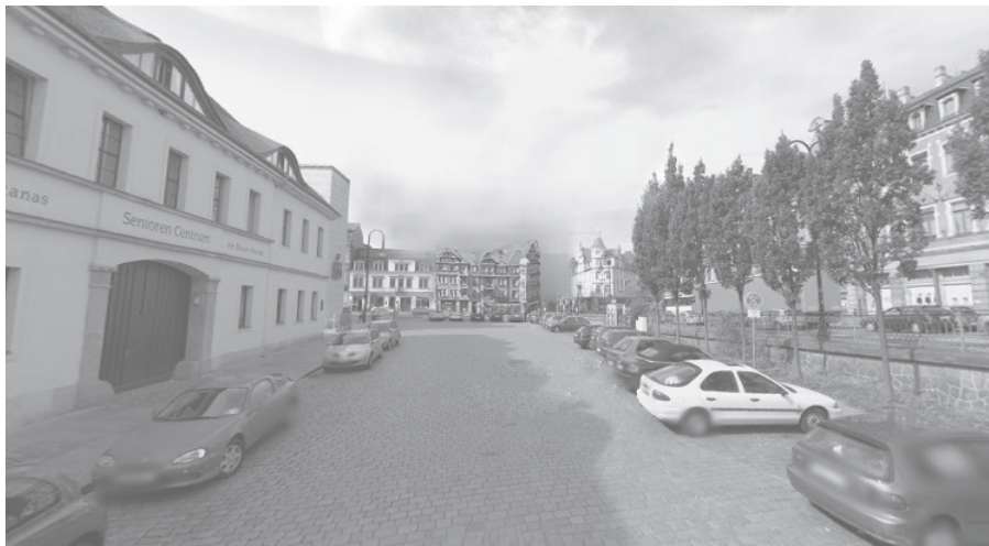
Abb.54.: Blick auf das Platzzentrum
