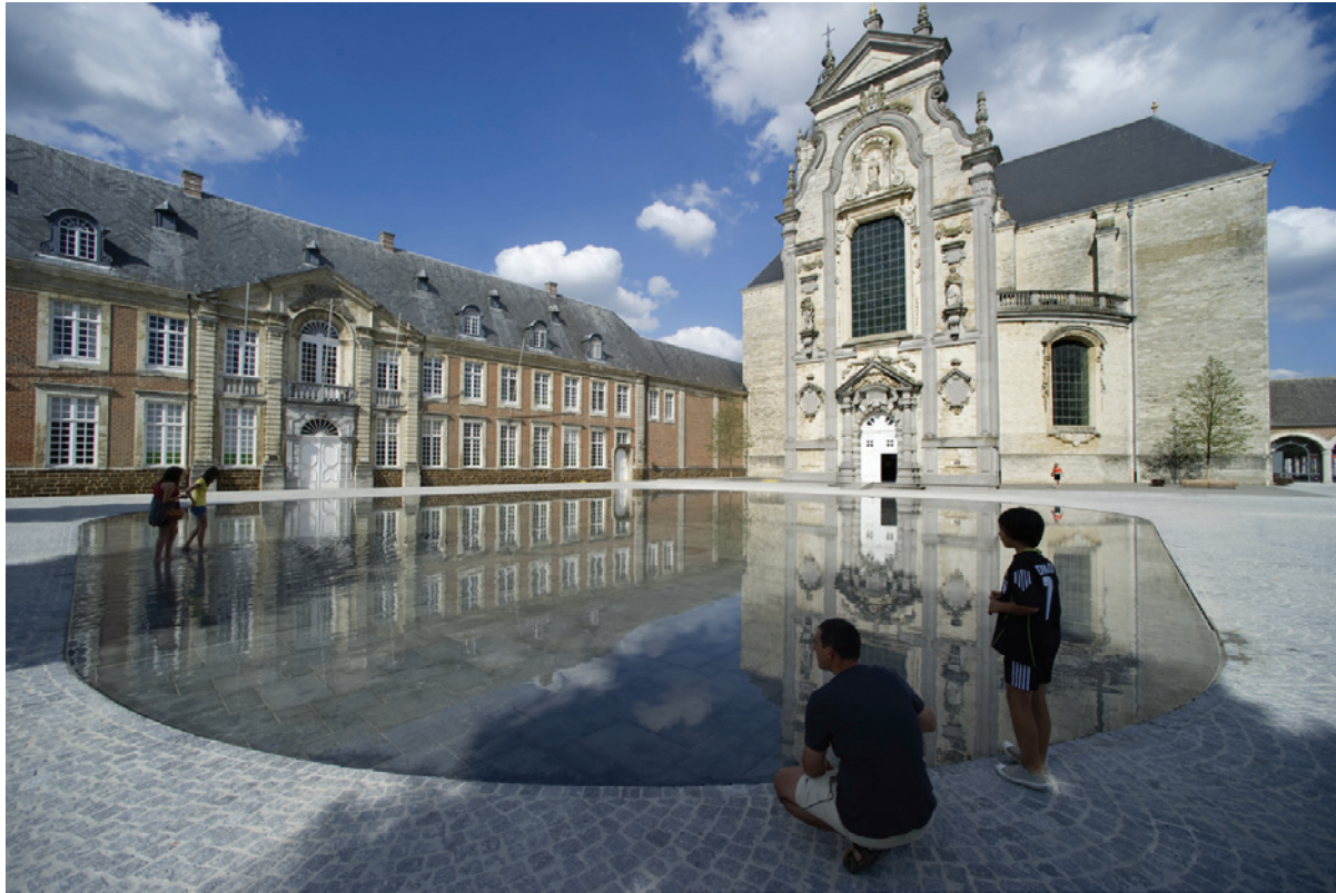
83. Blick von der Ecke
