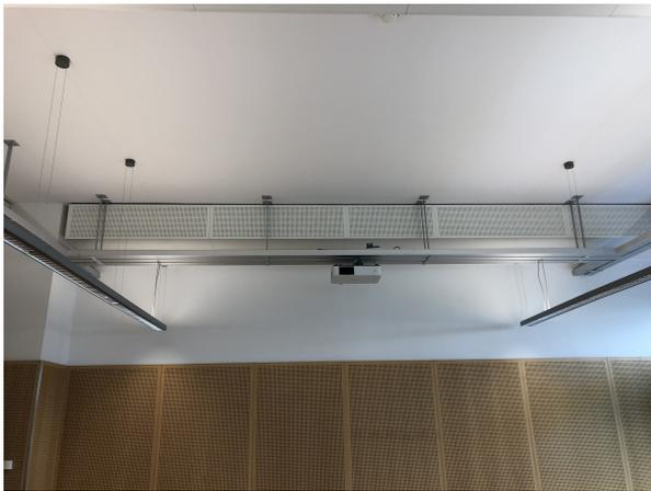
(a) Einbau Kantenabsorber an hinterer Wand.
