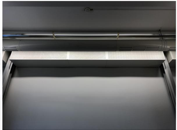
(b) Einbau Kantenabsorber im Bereich der Tafel.
