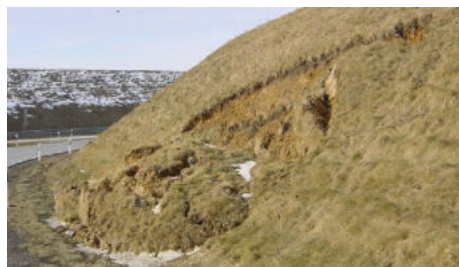
(b) Böschungsbruch 4
