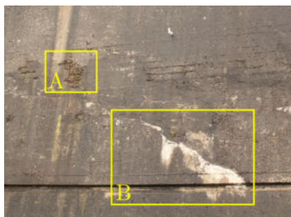
(a) A Bewehrungskorrosion, B Aussinterung
