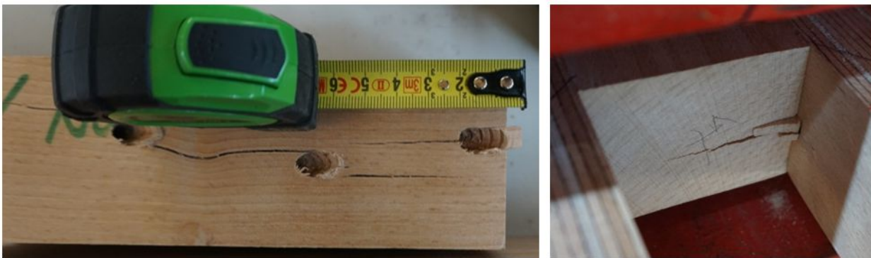
Abbildung 4-28 links: Aufspalten entlang einer Schraubenreihe; rechts: Ausscheren eines kleinen Blockes an der Hirnholzseite; aus [67]
