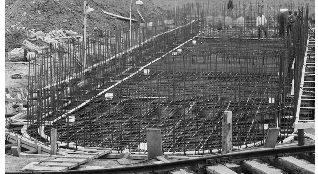
Abbildung 2.2: Pfahlkopfplatte Neckartalübergang [LBW]
