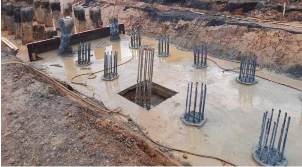
Abbildung 2.1: Pfahlbewehrung einer Pfahlkopfplatte [KHP]
