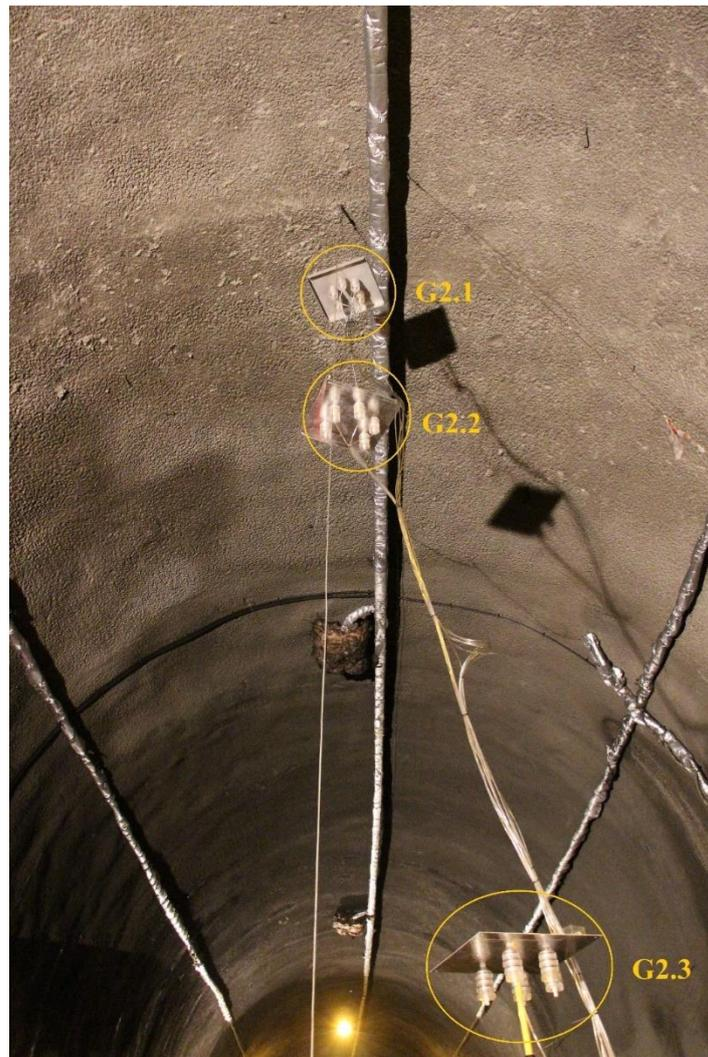
Abbildung 7-35 Positionen der Gasmessung im Detail
