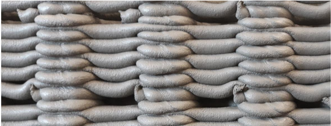
Abb. 137: Herstellung einer Lochstruktur durch 3D-Betondruck
