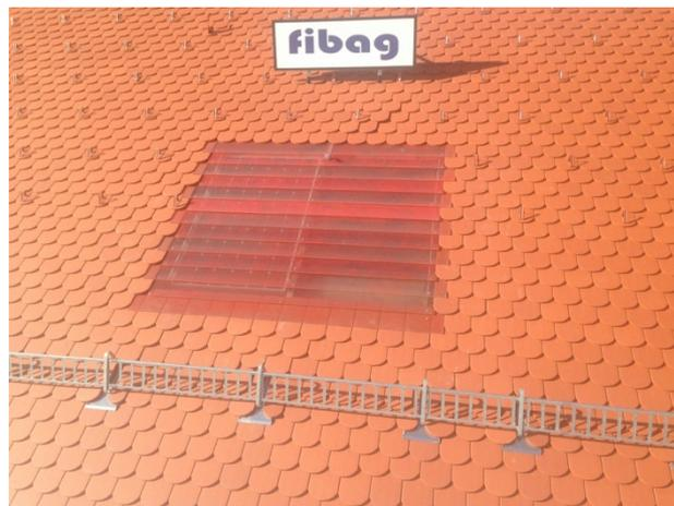
Abb. 21: Abbildung des Prototyps, SKIN® energyroof- moduls
