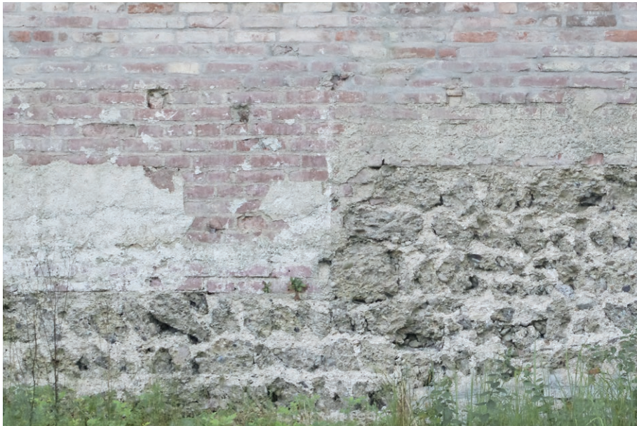
Abb. 1: Mauerschichten auf dem Planungsgrundstück
