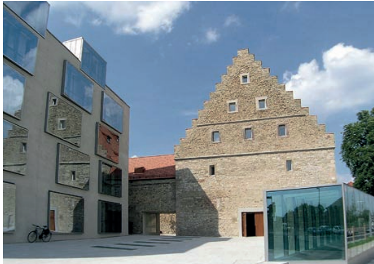
Abb. 49: Neue Bibliothek in der Zehntscheune
