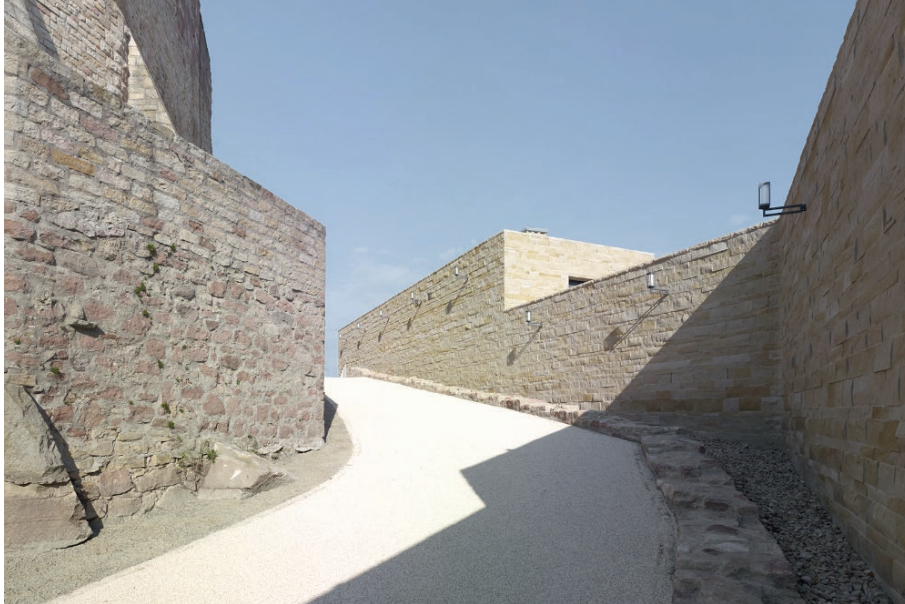
Abb. 68: Alte und neue Mauer
