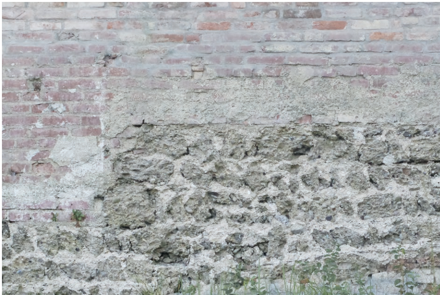
Abb. 45: Mauerschichten der historischen Stadtmauer
