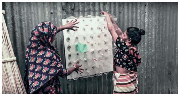
Abb. 4.4 Bangladesh - DIY Kühlpaneel aus alten PET Flaschen
