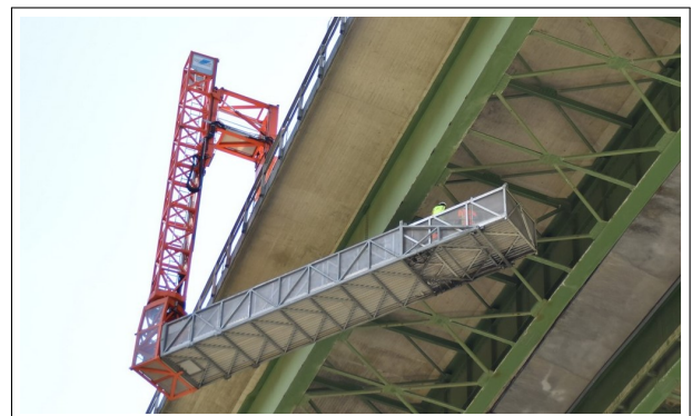
(b) Schwenkbare Positionierung von einem Brückeninspektionsgerät [Ranalter, 2018].
