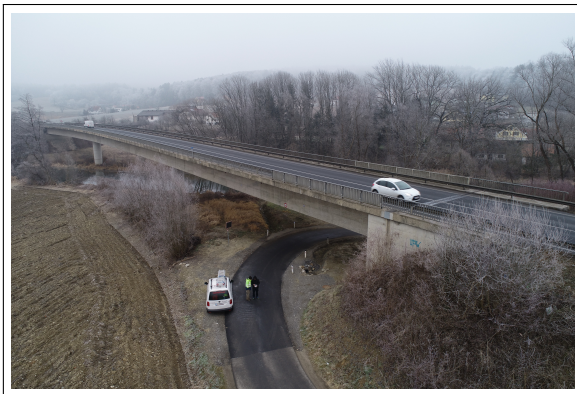
(a) Südwestliche Brückenansicht
