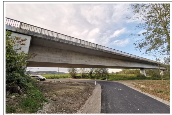
(b) Südöstliche Brückenansicht
