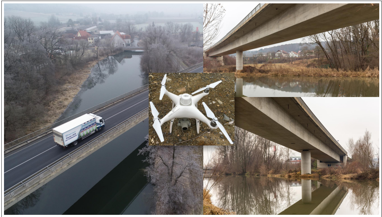
Abbildung 5.2: Optimale Aufnahmebereiche durch die Drohne (DJI Phantom 4 RTK) bei dem Referenzobjekt.
