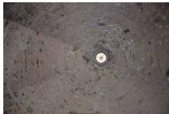
Fig. 492: Öffnung im Kuppelgewölbe des Untergeschosses von Perschen N° 01. CA 2014.
