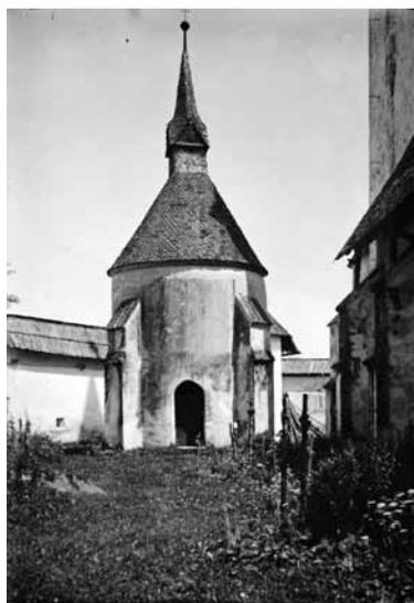
Fig. 447: Karner Untergreutschach N° 67 mit steinschindelgedecktem Dach und viereckigem Dachreiter. Aufnahme Ginhard 1927, Bildarchiv des BDA Kärnten.
