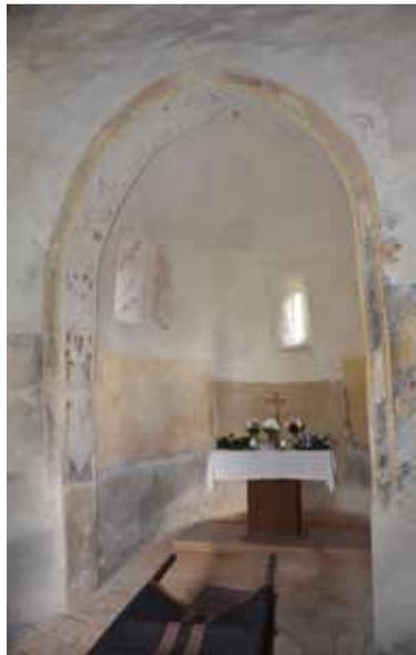
Fig. 576: Chorbereich des Karners in Stannern N° 06 mit drei Rundbogenfenstern in Trichterlaibung. CA 2014.
