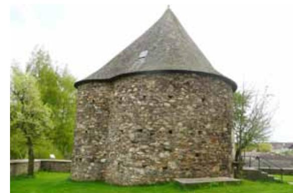
Fig. 410: Lochstruktur an der Nordfassade des Karners von Großgöttfritz. CA 2010.
