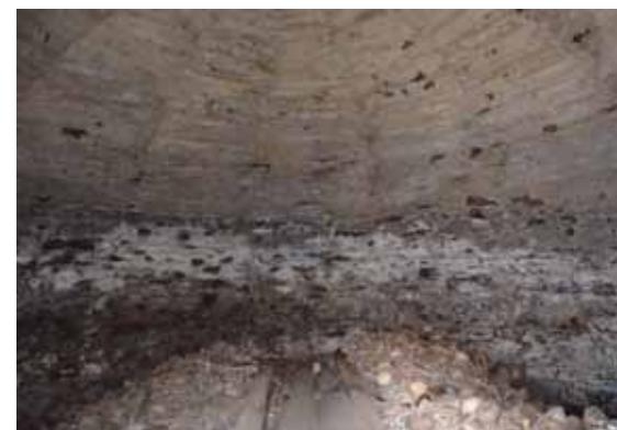
Fig. 413: Klostergewölbe im Untergeschoss von St. Marein N° 49 mit deutlichen Spuren der Lehrschalung. CA 2012.
