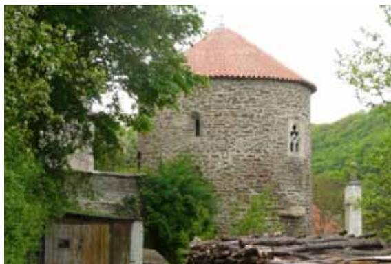
Fig. 399: Das Bruchsteinmauerwerk des Karners in Hardegg N° 12, aus schmalen Einzellage mit relativ starken Mörtelfugen. CA 2008.
