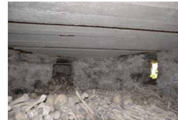
Fig. 490: Stahlbetondecke des Beinhauses von Tigring No 72 mit einer vermauerten Öffnung an der Nordseite. CA 2013.
