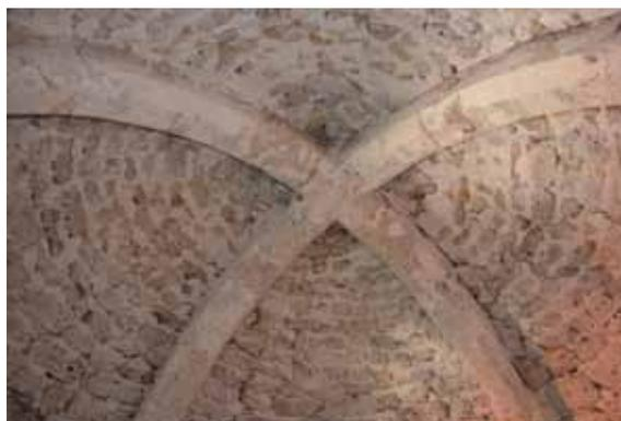
Fig. 595: Kuppelgewölbe mit 4 Gurtbögen aus Sichtmauerwerk in Gorenji Mokronog N° 92. CA 2012
