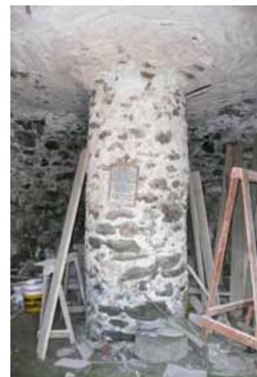
Fig. 509: Gedrungene Mittelsäule mit sehr flacher Ringtonne im Untergeschoss des Karners Berg N° 62. CA 2010.
