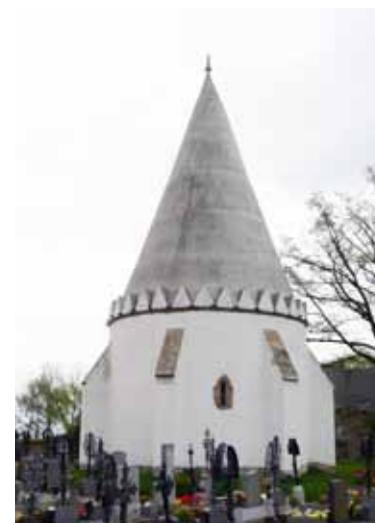
Fig. 453: Karner Friedersbach N° 16 mit massiver, aufgemauerter Dachkonstruktion. CA 2010.
