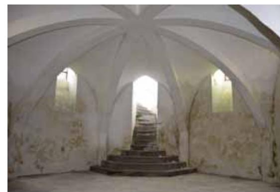
Fig. 516: Gewölbe mit 8 Gutbögen im zum Kapellenraum umgenutzten Untergeschoss des Karners in Mühlendorf N° 05. CA 2014.
