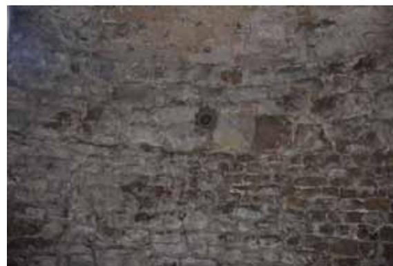
Fig. 391: Mauerwerk im Untergeschoss des Karners in Perschen mit erkennbar unterschiedlichen Steinformaten. CA 2014.
