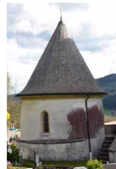
Fig. 445: Nordwestansicht des Karners in Bad St. Leonhard N° 59 mit Holzschindeldeckung und Aufschiebling in der Traufzone. CA 2013.
