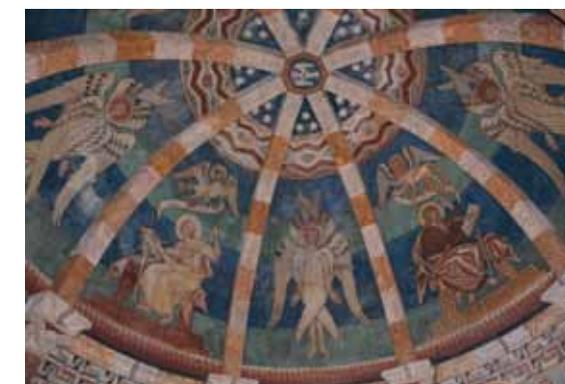
Fig. 437: Gurtbögen im Gewölbe des Ober- und Untergeschosses im Karner in Hartberger N° 55 mit 8 Gurtbögen oben und 4 unten. CA 2012.
