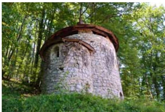
Fig. 396: Mauerwerk des Karners Gorenji Mokronog N° 92, mit relativ großformatigen Steinen und lagegerechtem Mauerwerk. CA 2012.
