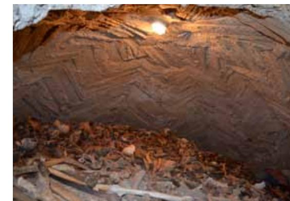
Fig. 414: Gewölbe mit schräggestellter Schalung im Untergeschoss des Karners von Lorch N° 35. CA 2013.
