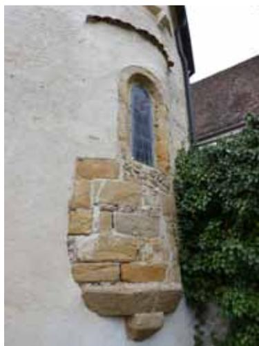
Fig. 423: Apsismauerwerk und Fenstereinfassung des Karners in Mauthausen N° 34. CA 2013.
