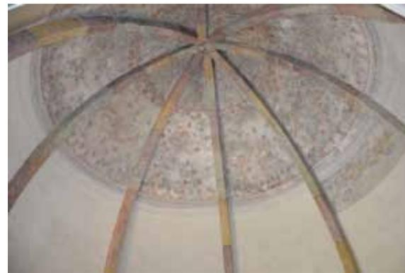
Fig. 602: Kuppel mit 8 Gurtbögen und malerischer Fassung in Mühlendorf am Inn N° 05. CA 2014.
