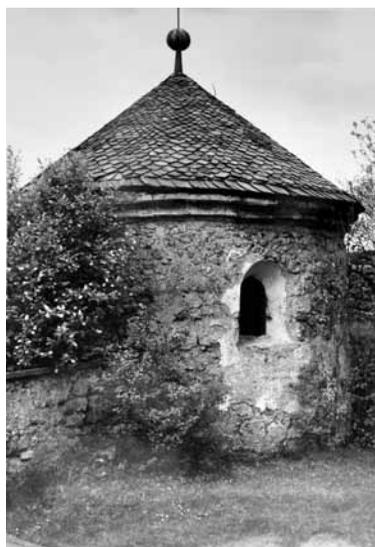
Fig. 438: Karner Stein im Jauntal N° 65, ziegelgedecktes Kegeldach mit 30° Neigung. Bildarchiv des BDA Kärnten 1965.
