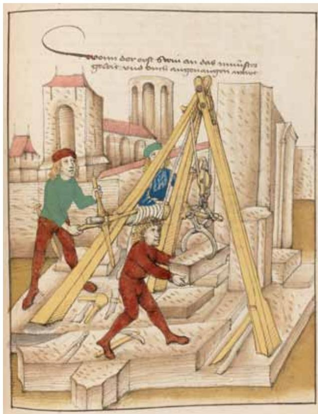
Fig. 77: Auf einem Dreibock mit Rolle und Aspel werden Quader mit der Steinzange in Position gehoben. Am Boden liegen Werkzeuge, Zirkel, Spitzfläche, Schlag-eisen und Schlägel. Spiezer Bilderchronik 1484/85, Diebold Schilling. Bern, Burgerbibliothek.
