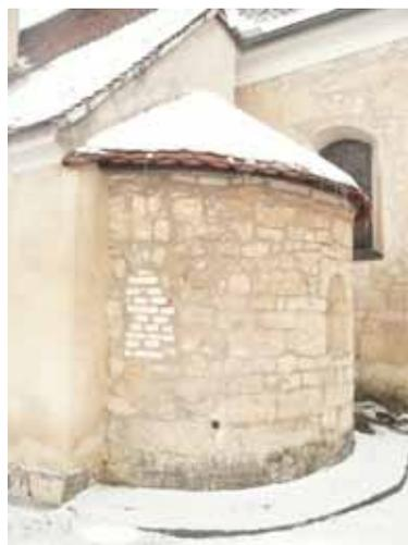
Fig. 424: Mauerwerk in Grafensulz N° 25 mit vermauertem Südfenster. CA 2010.
