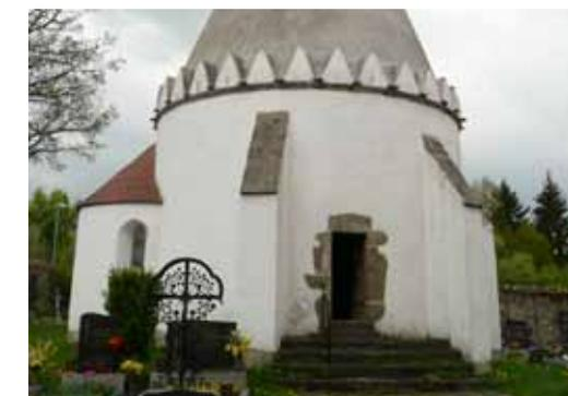
Fig. 422: Der Karner Friedersbach nach der Sanierung mit mehrschichtig aufgebrachtem, gekalktem Außenputz. CA 2010.
