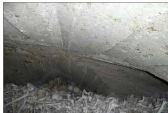
Fig. 496: Untergeschoss des Karners in Radsberg N° 86 mit den erkennbaren Stichbögen der kreuzgratgewölbten Decke. CA 2008.
