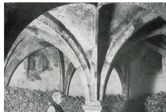
Fig. 17: Gotisches Gewölbe mit Mittelsäule im Untergeschoss des achteckigen Karners des Stiftes Zwettl. Buberl 1940.
