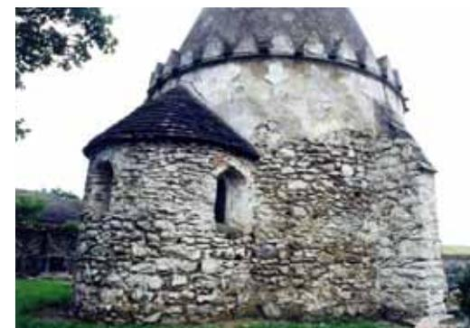
Fig. 421: Der Karner von Friedersbach N° 16 vor der Sanierung, am oberen Teil noch deutliche Spuren des Außenputzes, 2006.
