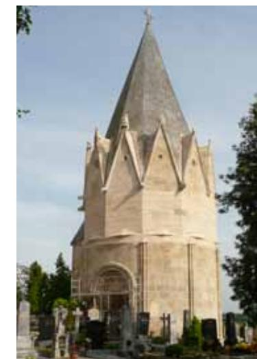
Fig. 454: Karner Pulkau N° 18 mit gemauerter Dachkonstruktion und Schindeldeckung. CA 2008
