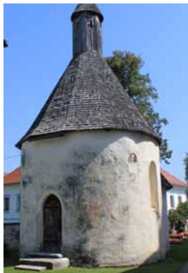
Fig. 418: Mehrschichtputz mit Spuren von Fresken am Karner Globasnitz N° 89. Commons 2009.
