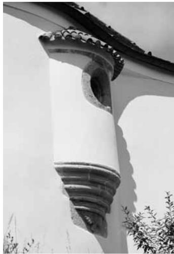
Fig. 256: Apsis des Karners in Allersburg mit den abgestuften Konsolplatten. CA 2013.
