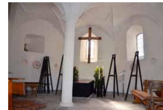
Fig. 614: Schlanke, runde Mittelsäule mit Sterngratgewölbe im Obergeschoss von Altenmarkt N° 64. CA 2014.
