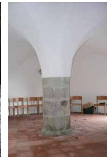
Fig. 511: Polygonale Mittelsäule mit Sterngratgewölbe im adaptierten Untergeschoss von Grossglobnitz. N° 14. CA 2010.
