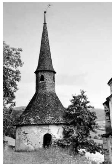
Fig. 448: Karner Deinsberg N° 66 mit Steinschindeldeckung und sechsseitigem Dachreiter. Bildarchiv des BDA Kärnten 1963.
