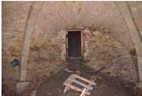
Fig. 499: Gurtbögen des Gewölbes im Beinhaus in Wullersdorf N° 23 mit der Zugangsöffnung an der Nordseite. CA 2014.
