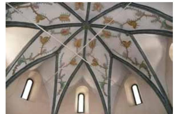
Fig. 610: Sternrippengewölbe in St. Veit an der Glan N° 68. CA 2008.
