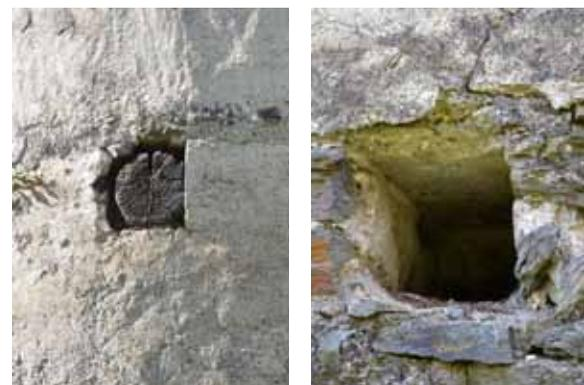
Fig. 408: Details der untereren Balkenreihe des Karners St. Marein. CA 2012.
