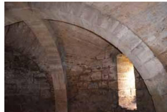
Fig. 503: Gewölbe im Untergeschoss des Karners in Hartberg N° 55 mit massiven Gurtbögen und dem Zugang an der Nordseite. CA 2012.
