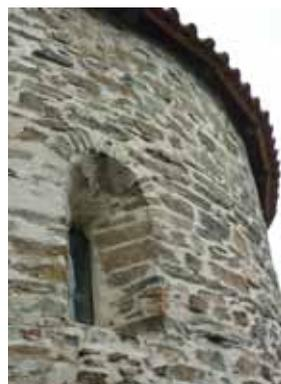
Fig. 401: Mauerung des Rundbogenfensters im Norden. CA 2008.
