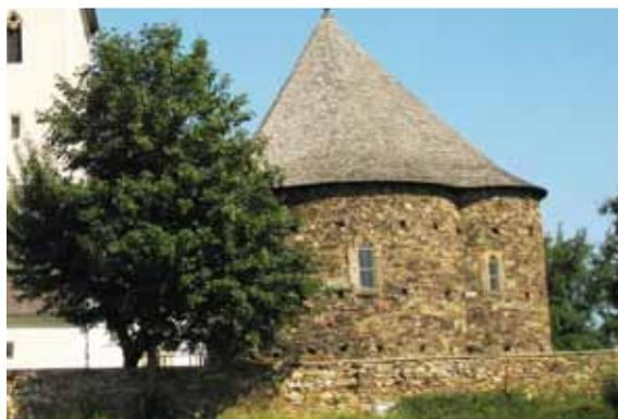
Fig. 409: Südfassade des Karners in Großgöttfritz N° 17 mit den drei Reihen der Einrüstlöcher im Außenmauerwerk. CA 1010.
