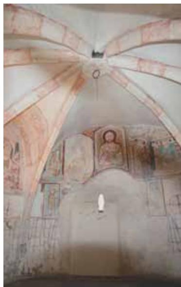
Fig. 568: Vermauerter Apsisbereich in Gmünd N° 61, der durch die Wandmalerei noch ablesbar ist. CA 2013.
