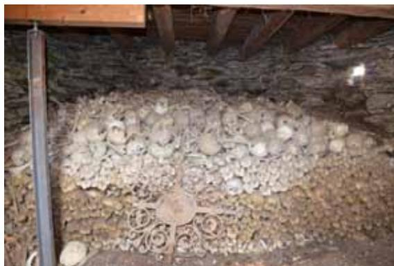
Fig. 485: Das Beinhaus von Glantschach No 69 mit der Holz balkendecke und nachträglicher Abpölung des Mittelbalkens. CA 2013.
