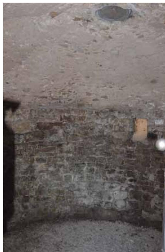
Fig. 515: Südöstliches Mauerwerk im Untergeschoss von Perschen N° 01 mit gut erkennbarem Übergang zur flachen Kuppel. CA 2014.
