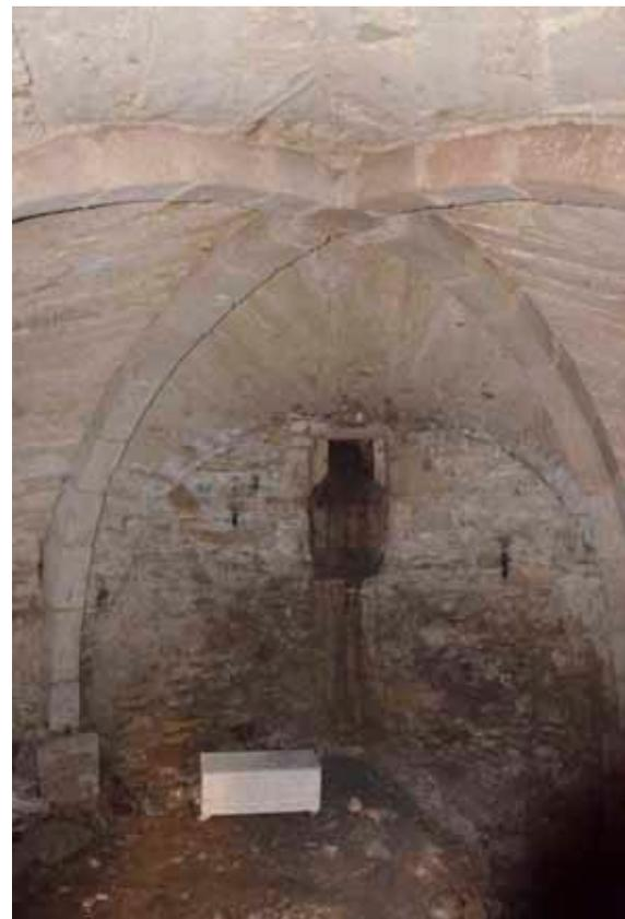
Fig. 502: Südseite in Wullersdorf mit teilweise vermauerter Wandöffnung unter der Gewölbekappe. CA 2014.
