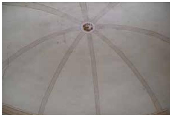
Fig. 594: Kuppelgewölbe mit aufgemalten Gurtbögen und Stuckrand in Bad St. Leonhard N° 59. CA 2008.
