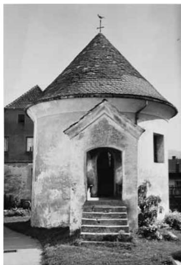
Fig. 440: Karner Reichenfels N° 58, ziegelgedeckt mit gemauertem Dachaufbau und 45° Dachneigung. BDA Bildarchiv Kärnten 1979.
