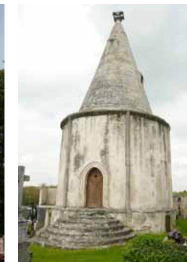
Fig. 455: Karner Burgschleinitz N° 21 mit gemauerter Dachkonstruktion. CA 2010.
