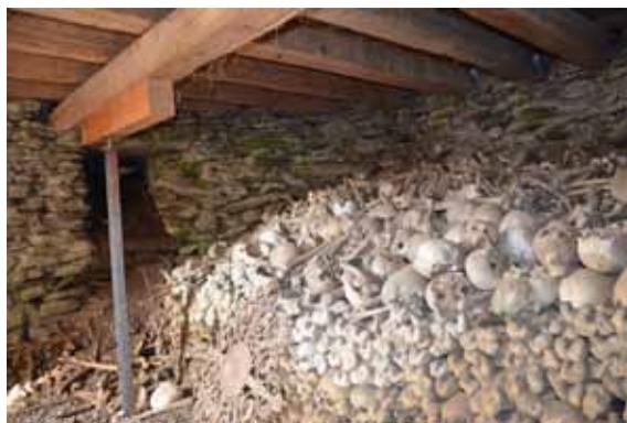
Fig. 487: Die Pölung des Mittelbalkens im Beinhaus von Glantschach No 69. CA 2013.
