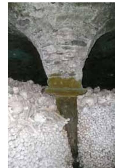
Fig. 510: Schlanke runde Mittelsäule mit Kämpferplatte und Ringtonne im Beinhaus von Pisweg N° 65. CA 2010.
