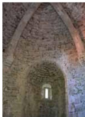
Fig. 398: Kapellenraum mit unverputztem Mauerwerk. CA 2012.
