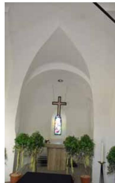
Fig. 573: Apsisbereich in Pöls N° 42 mit einem kleinen Spitzbogenfenster in Trichterlaibung. CA 2015.
