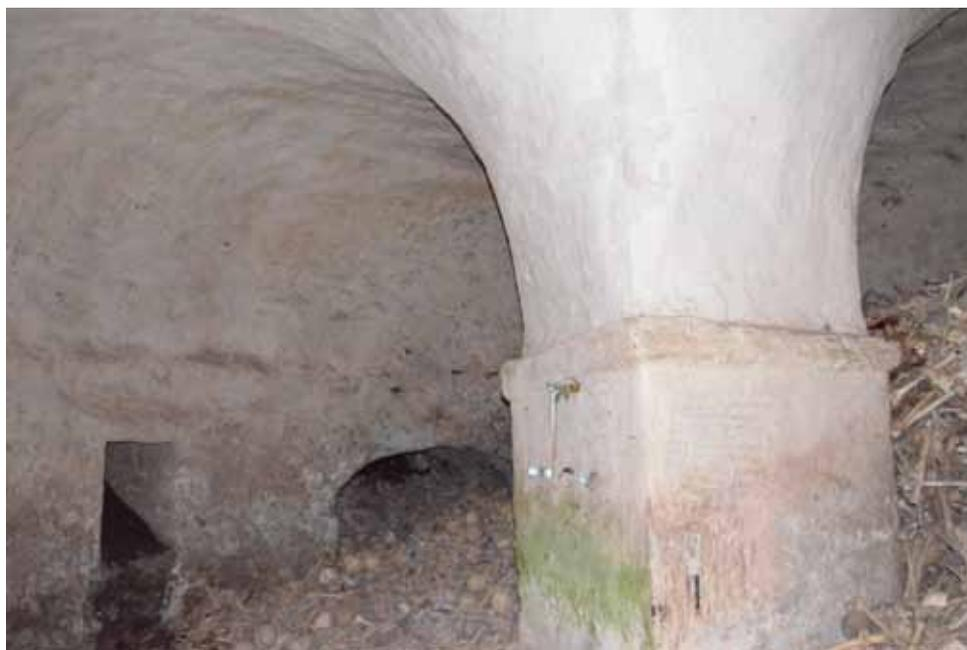
Fig. 507: Quadratischer Mittelpfeiler mit Kämpferplatte und Ringtonnengewölbes im Beinhaus von St. Lambrecht N° 48, im Hintergrund die Lüftungöffnung und Apsisuntermauerung an der Ostseite des Karners. CA 2012.
