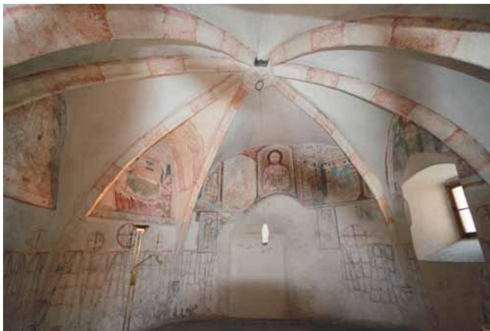
Fig. 611: Siebenteiliges, farbig gefasstes Rippengewölbe im Kapellenraum von Gmünd N° 61 mit der vermauerten Apsisnische und dem erweiterten Südfenster. Commons 2010.
