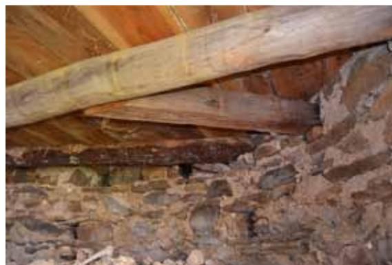
Fig. 484: Auflagerdetail an Ostseite des Beinhauses in St. Peter im Lavanttal No 57, darunter rechteckige Lüftungsöffnungen im Mauerwerk. CA 2013.
