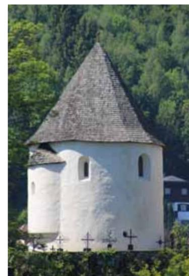
Fig. 444: Nordansicht des Karners in Maria Wörth N° 73 mit Holzschindeldeckung und Aufschiebling in der Traufzone. Commons 2011.
