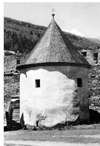
Fig. 347: Südostansicht des Karners in Gmünd. Anstelle der abgebrochenen Apsis sind Ausbesserungen am Mauerwerk und ein Fenster erkennbar. Bildarchiv BDA Kärnten.
