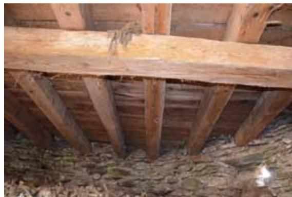
Fig. 486: Mittlerer Balken der Holz balkendecke im Beinhaus von Glantschach No 69. CA 2013.
