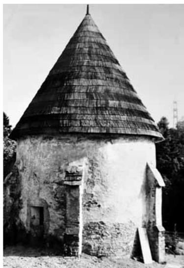
Fig. 441: Nordansicht des Karners in St. Agnes N° 83 mit verwitterter Lärchenholzschindeln. Bildarchiv des BDA Kärnten 1967.
