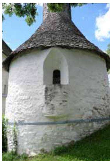
Fig. 417: Einschichtputz am Karner von Deinsberg N° 66 mit gut sichtbarer Mauerstruktur. CA 2008.
