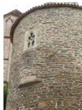
Fig. 400: Steingefasstes Fenster der auskragenden Apsis. CA 2008
