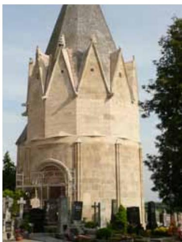
Fig. 433: Nordwestfassade des Karners in Pulkau N° 18 mit unterschiedlichen Steinformaten im unteren und oberen Bereich. CA 2008
