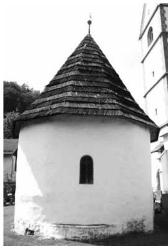
Fig. 349: Ostansicht des Karners in St. Margarethen ob Töllerberg, im Sockelbereich ist der Verlauf der abgebrochenen Apsis noch ansatzweise erkennbar. CA 2008.
