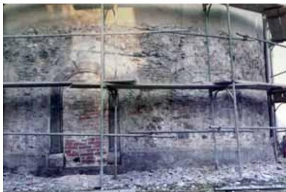
Fig. 411: Freigelegtes Mauerwerk während der Renovierungsarbeiten am Karner von St. Veit N° 68. BDA Bildarchiv Kärnten 1983.
