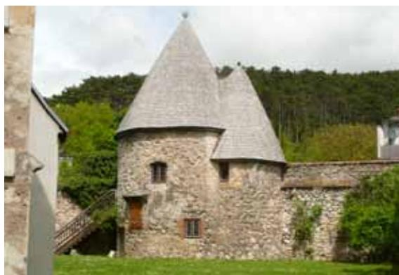
Fig. 402: Bruchsteinmauerwerk des Karners in Pottenstein N° 32 aus sehr unterschiedlichen Steinformaten. CA 2010.
