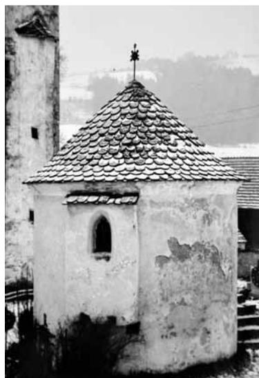
Fig. 439: Karner St. Peter im Lavantal N° 57, hier noch mit Steinschindeln gedeckt, heute mit Holzschindeln, Kegeldach mit 40° Neigung. Bildarchiv BDA Kärnten/Hartwanger 1972.
