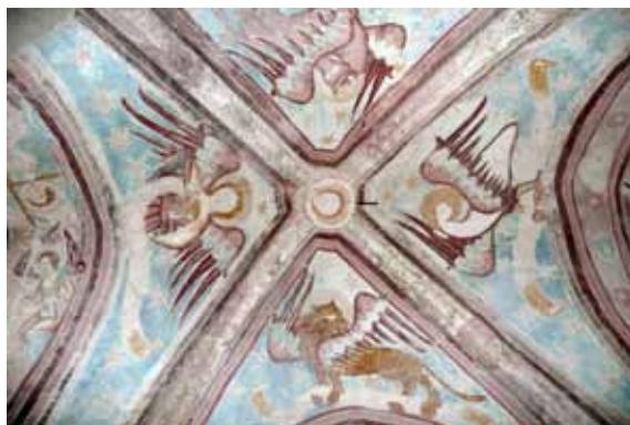
Fig. 597: Bemaltes Kuppelgewölbe mit 4 Gewölberippen in Untergreutschach N° 76, CA 2008.
