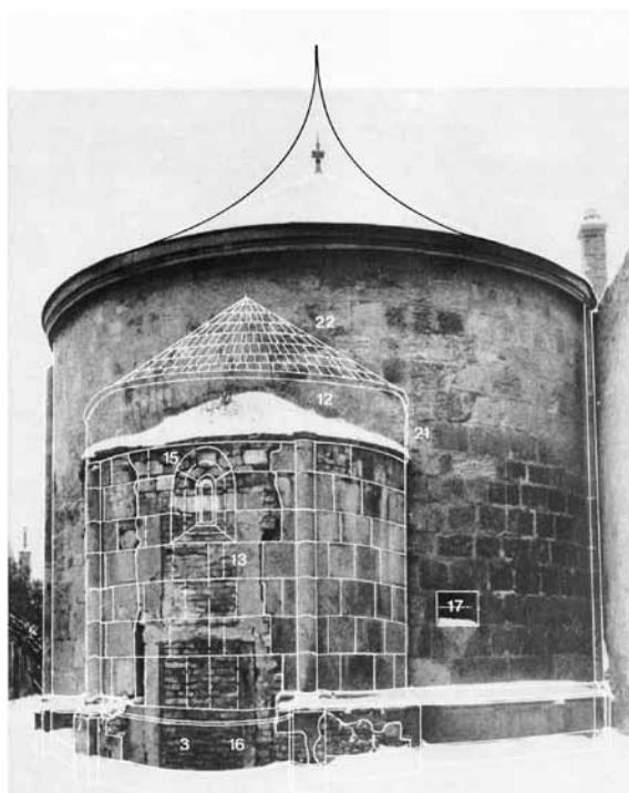
Fig. 706: Rekonstruktion der Apsis des Karners in Hainburg. Haderer 1991.
