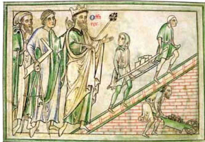
Fig. 74: Eine Darstellung der wichtigsten, am Bau einer Kathedrale beteiligten Personen. Links stehen hintereinander der Bauherr (der angelsächsische König Offa), dahinter sein Werkmeister (mit Bodenzirkel und Winkel) und sein Bauverwalter. Daneben transportieren zwei Arbeiter Steinquader über eine Laufschräge nach oben, darunter ein weiterer Arbeiter mit beladener Schubkarre. Illustration der Vita der hll. Albanus und Amphibalus um 1250; Dublin, Trinity College Library. Vgl. Binding 2010:10.
