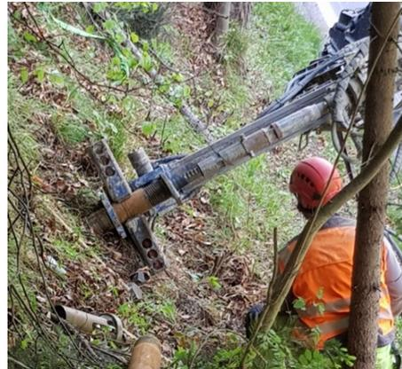
Abb. 1: Links: IBO-Mikropfahl; Rechts: Verrohrte Bohrung
