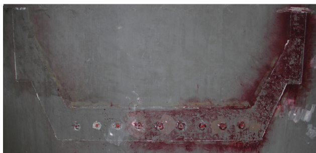
Abbildung 4.42 – Schalungsfläche West nach Ausschalen
