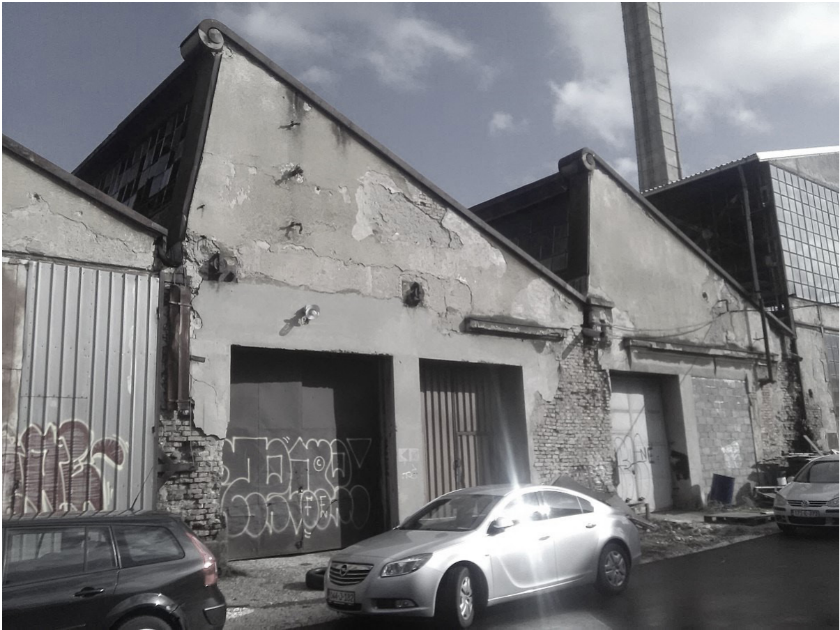
Abb. 15: Ehemalige Eisenbahnwerkstatt Vaso Miskin Crni
